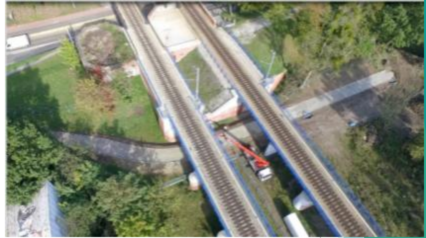
Wiadukt kolejowy przy ul. Osobowickiej
