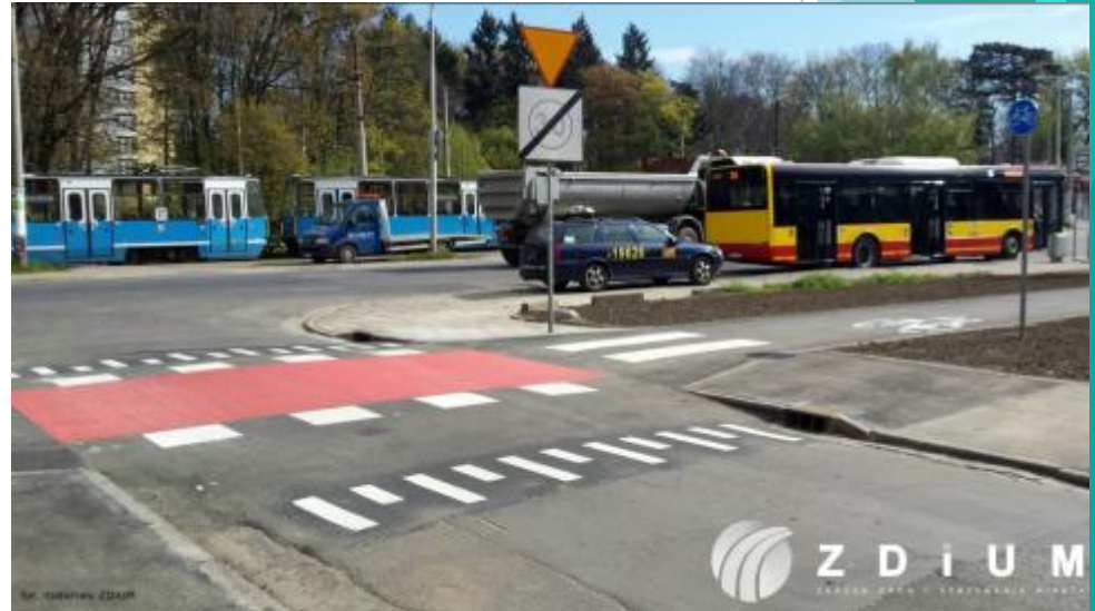
Wyniesienia przejazdów rowerowych i przejść pieszych
