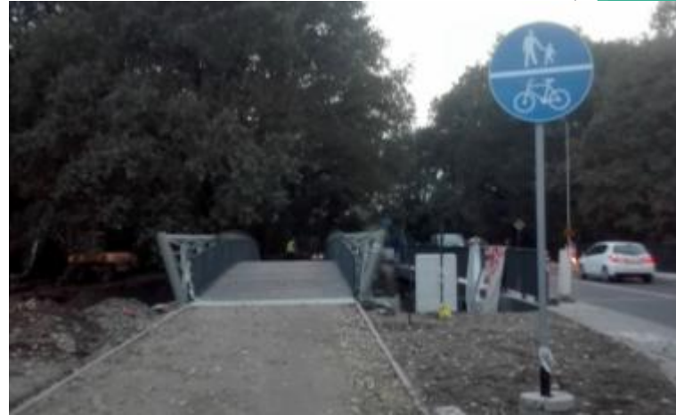
Kładka nad Ślężą przy Ostrowskiego
