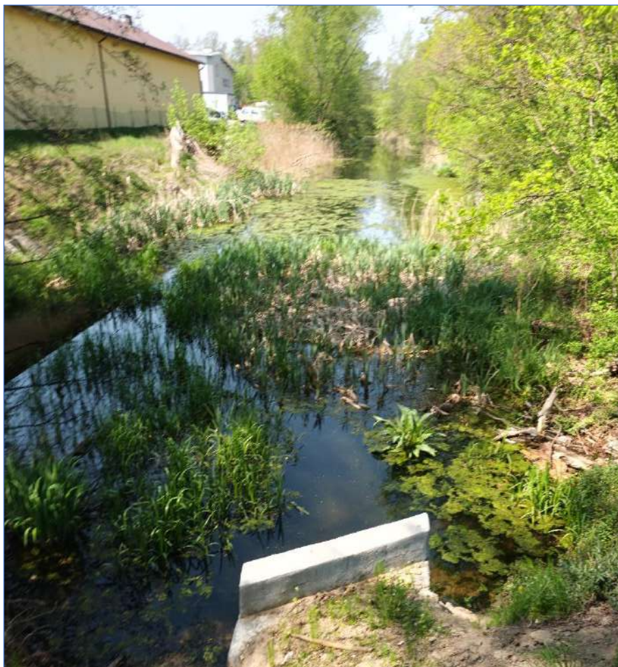
Zdjęcie 5 Zbiornik I - widok od strony nasypu kolejowego 72
