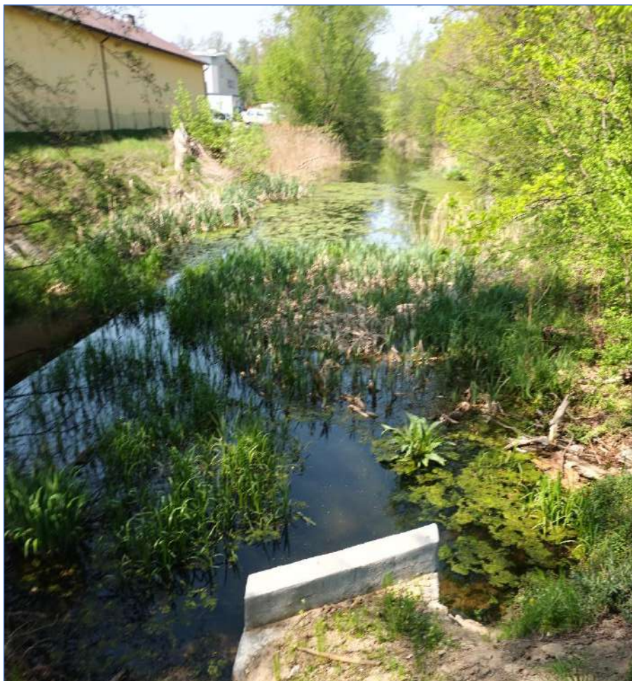
Zdjęcie 5 Zbiornik I - widok od strony nasypu kolejowego 26
