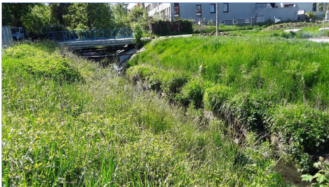
Zdjęcie 2 Zarośnięte skarpy koryta rzeki Kasiny na wysokości mostu drogowego ciągu ul. Stanisławowskiej (Muchobór Wielki) 4
