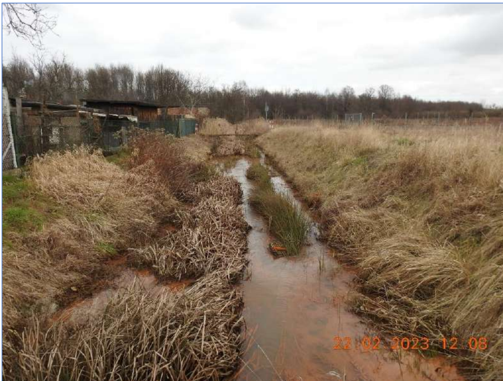
Zdjęcie 1 Zarośnięte i wypłycone koryto rzeki Ługowiny na odcinku poniżej ul. Trójkątnej (Leśnica) 2
