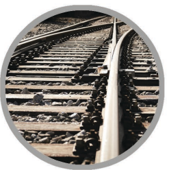
ELEMENTY INFRASTRUKTURY KOLEJOWEJ
