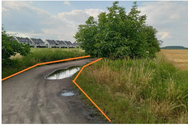
Rys. 4 – Widok na ścieżkę – odcinek środkowy w kierunku Wojszyc
