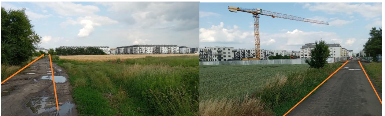
Rys. 6 – Widok na ścieżkę – odcinek końcowy w kierunku Jagodna
