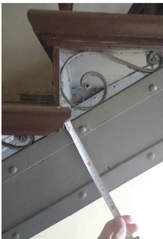
Fot. 81 Detal biegu schodowego. Dobry stan techniczny elementów stalowych.
