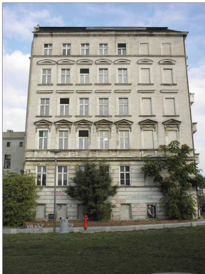
Fot. 6 Kamienica; elewacja południowa
