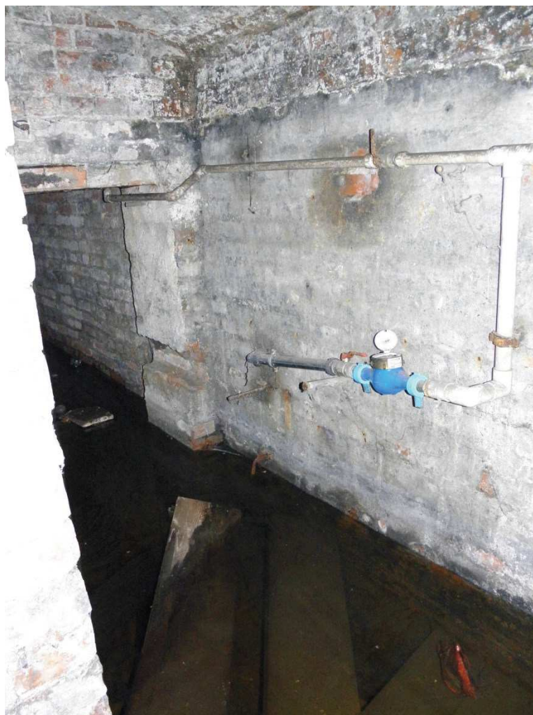
Fot. 73 Zawilgocenie ścian piwnic. Brak zarysowań. Woda trwale zalegająca w piwnicy. Poziom zwierciadła wody zmienny.
