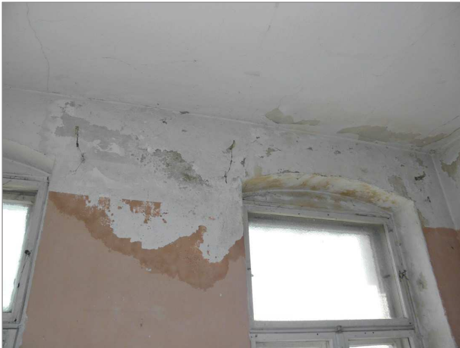
Fot. 32 Zacieki na połączeniu z płyta balkonową. Elewacja wschodnia
