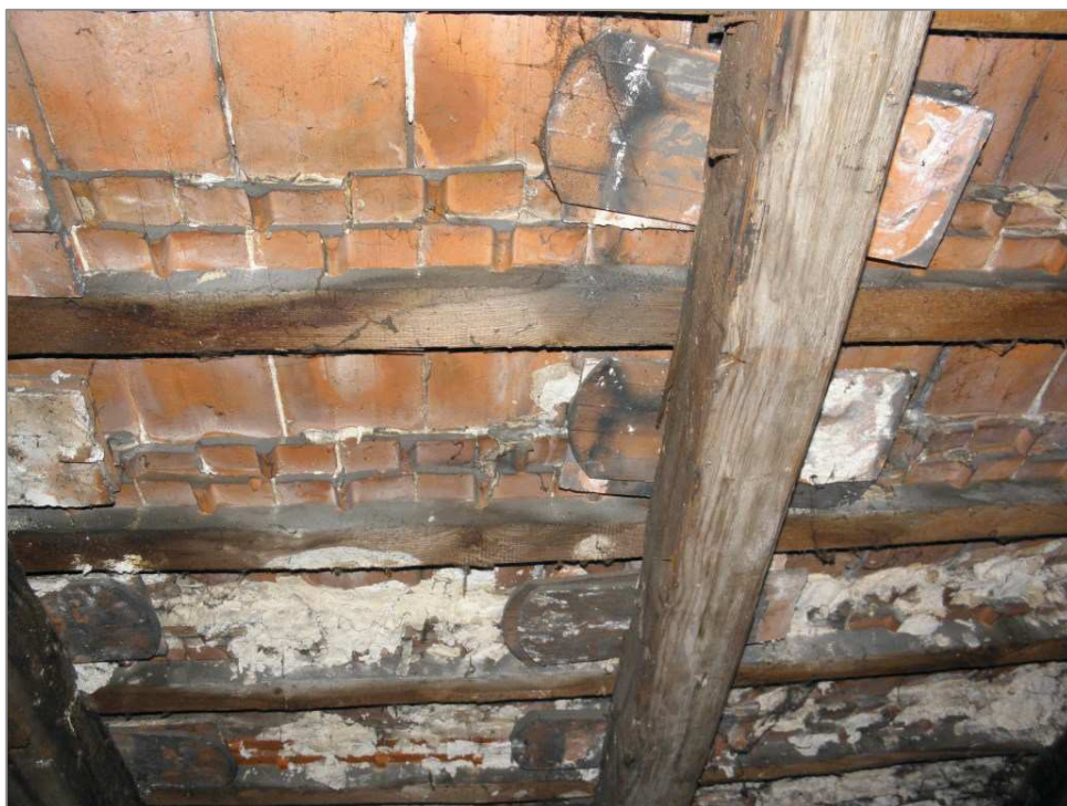
Fot. 59 Dachówka karpiówka. Liczne ściany prób naprawy pokrycia.
