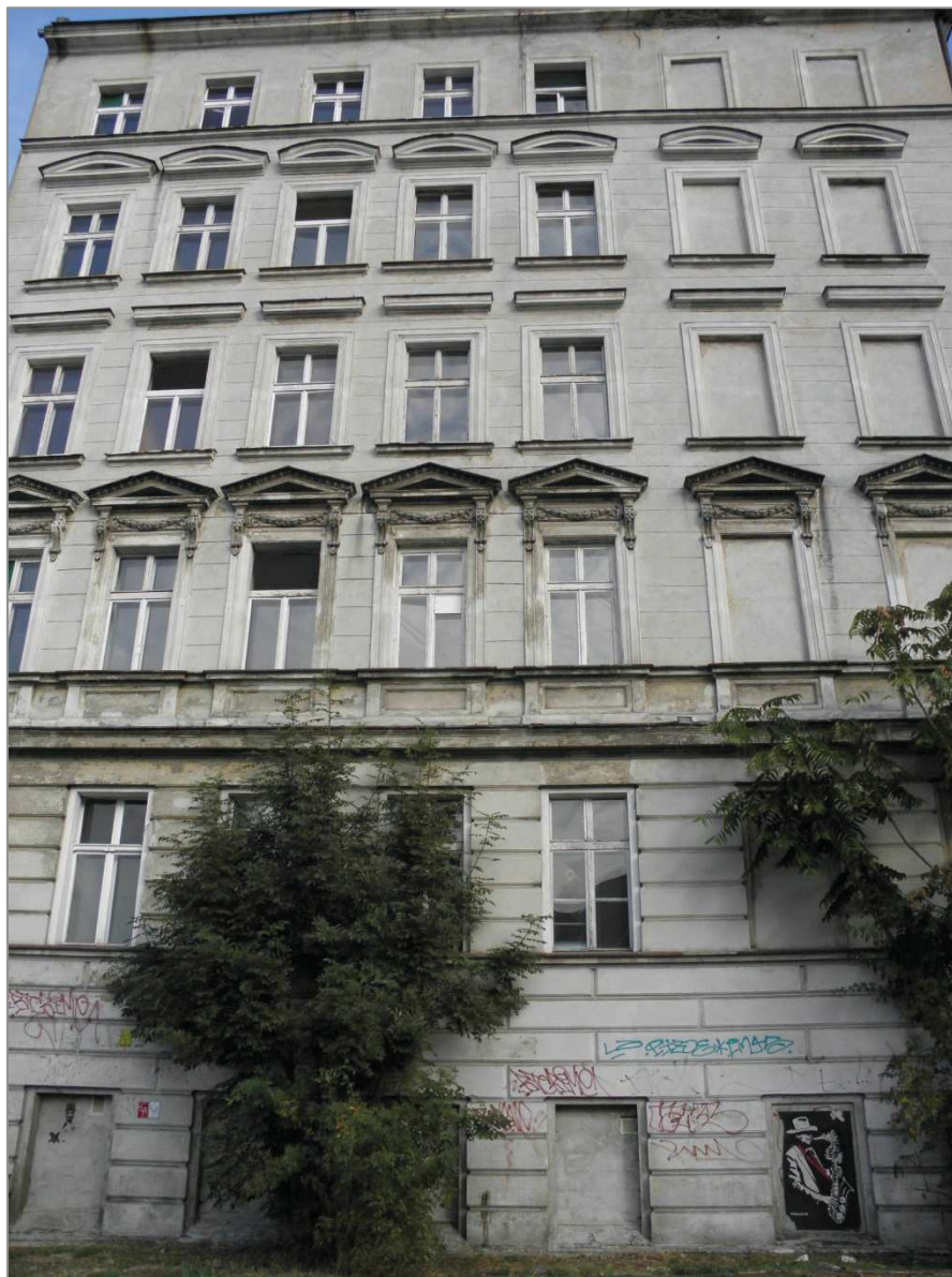
Fot. 14 Elewacja południowa
