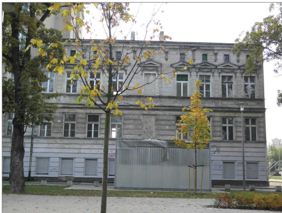
Fot. 67 Elewacja północna
