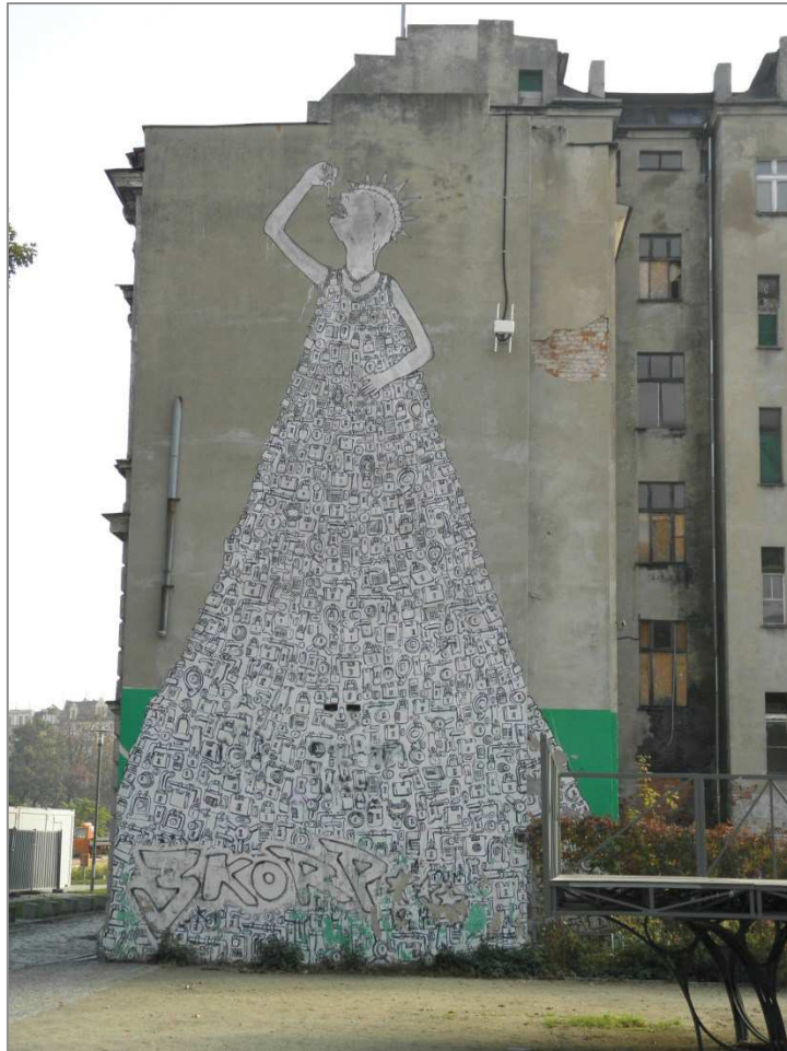
Fot. 65 Elewacja zachodnia
