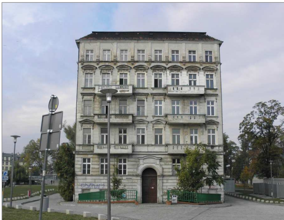
Fot. 1 Kamienica; elewacja wschodnia
