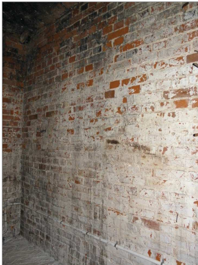
Fot. 28 Ściany przyziemia od strony wewnętrznej. Dobry stan techniczny.
