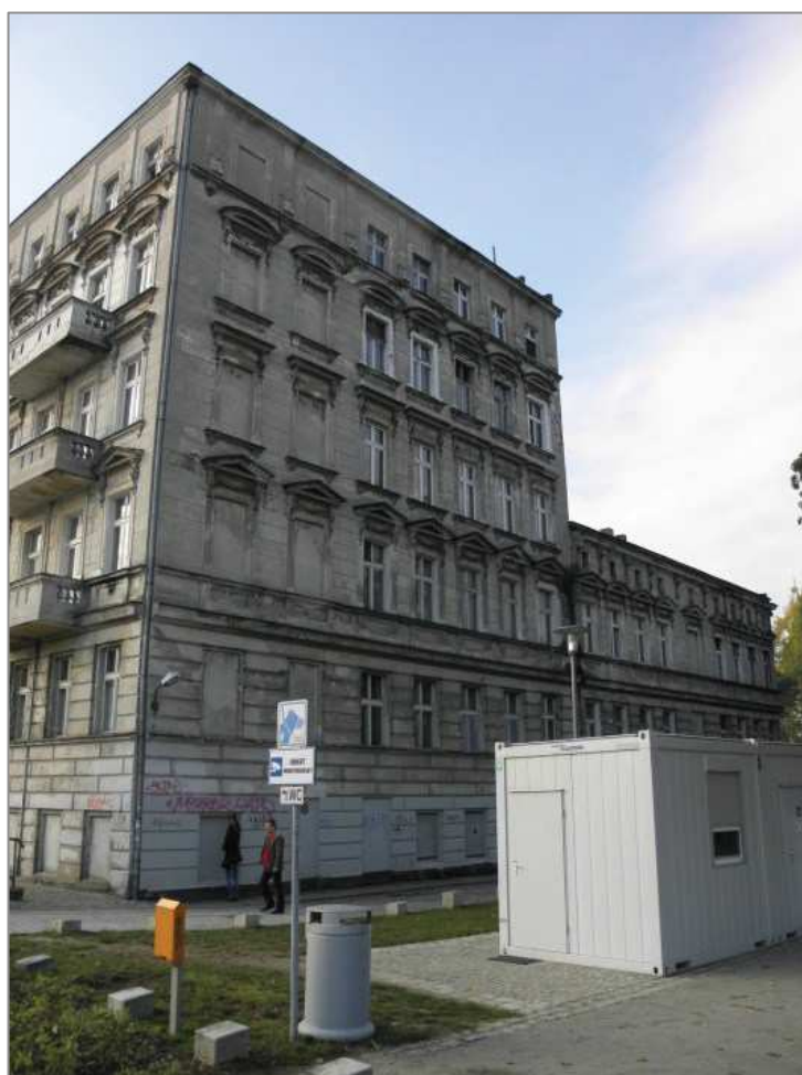
Fot. 2 Kamienica i oficyna; elewacja północna
