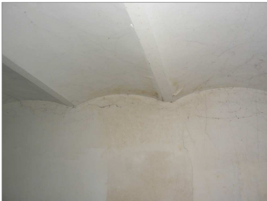
Fot. 38 Strop nad suteroną od strony wschodniej, otynkowany. Stan techniczny dobry
