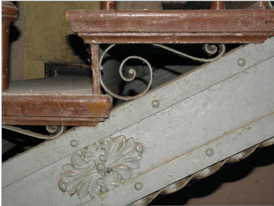
Fot. 46 Detal biegu schodowego. Dobry stan techniczny elementów stalowych.
