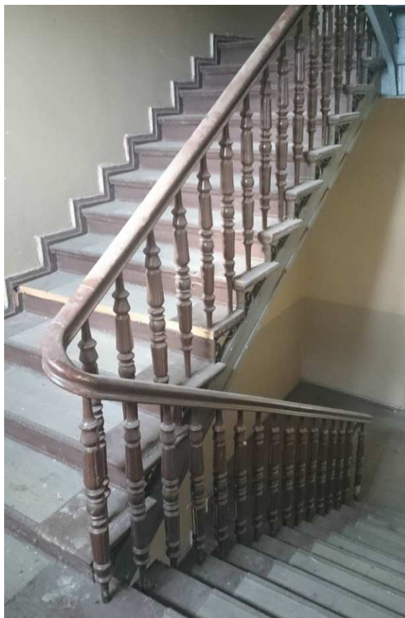
Fot. 80 Ogólny widok klatki schodowej. Dobry stan techniczny elementów stalowych.
