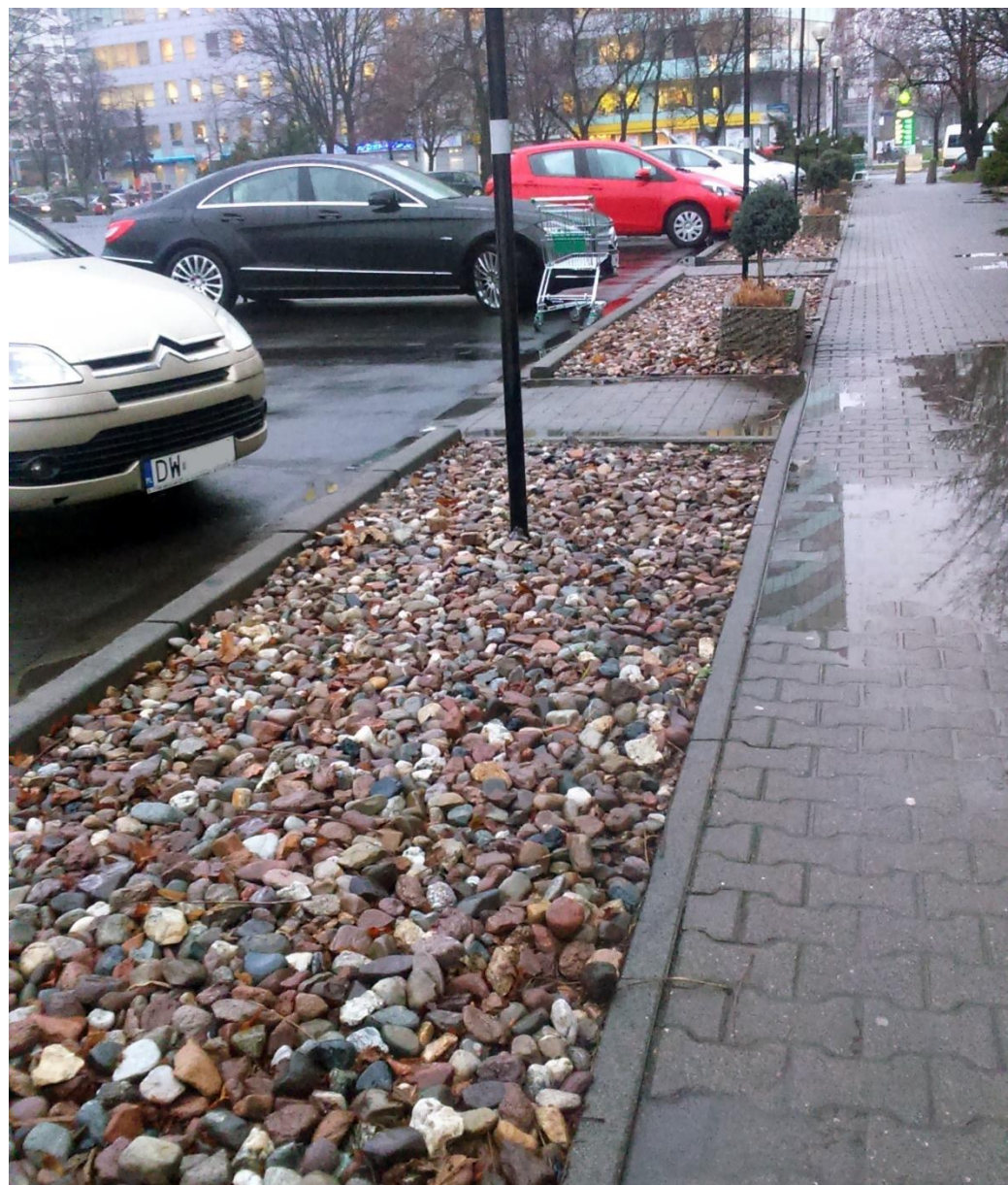
Row infiltracyjny wykorzystany do odwodnienia parkingu, Wrocław (fot. E. Burszta-Adamiak)
