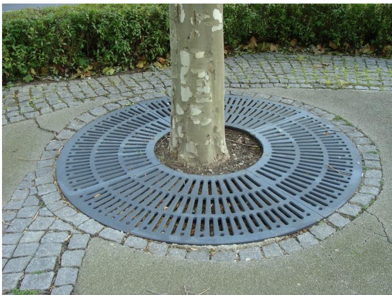
Przykład okrągłej kraty ochronnej na powierzchni pod drzewem (fot. J. Dąbrowska)
