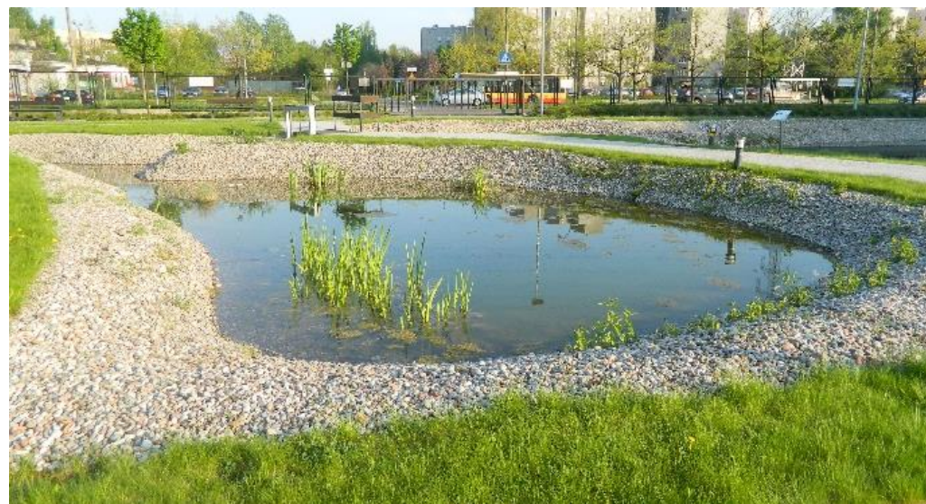
Stanowiska pilotowe stawów hydrofitowych w Centrum Wodnym SGGW, Warszawa (fot. E. Burszta-Adamiak)
