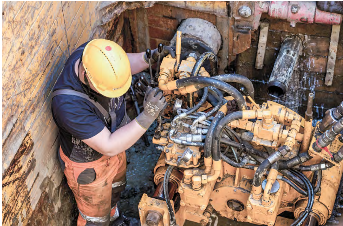
Prace w wykopie podczas rozbudowy sieci kanalizacyjnej na wrocławskich Strachowicach w marcu 2025 roku
