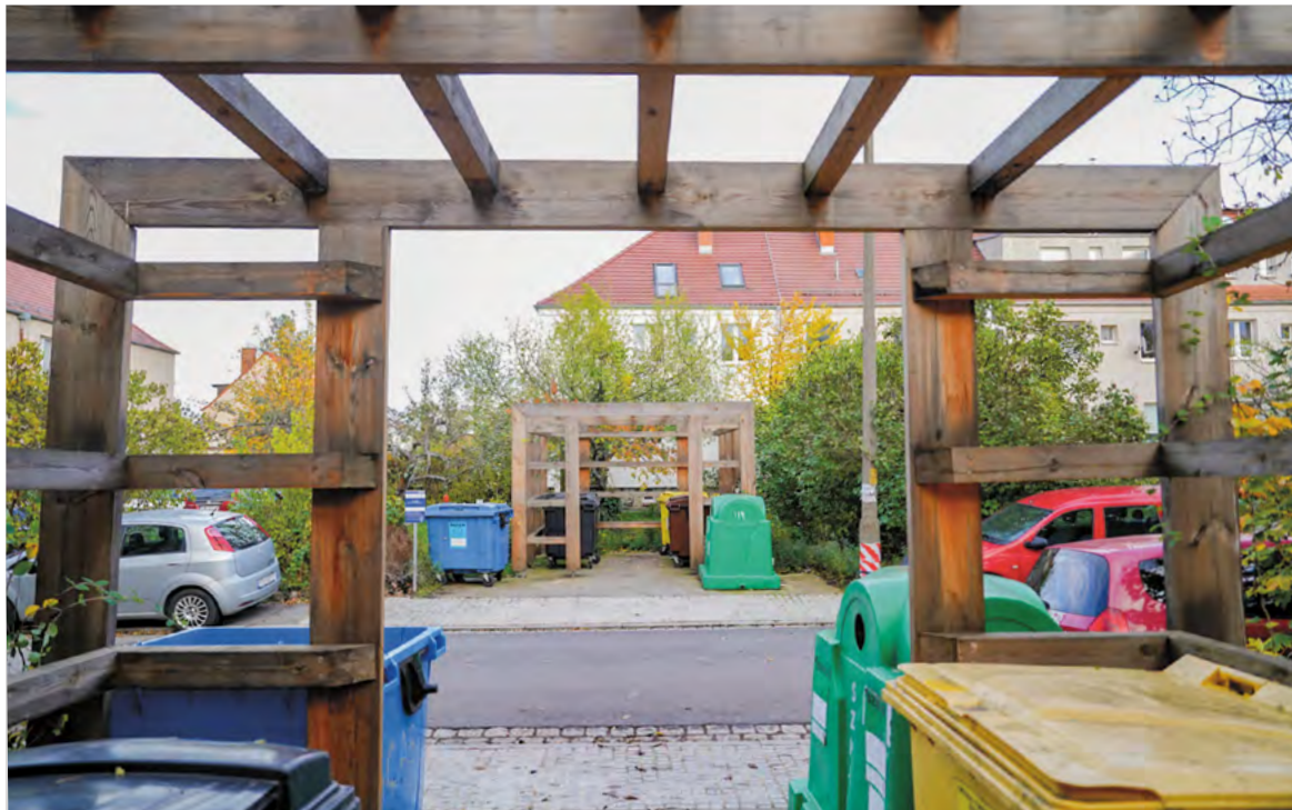
W południowej części Sępólna powstało już 16 miejsc zbiórki odpadów, a docelowo powstanie ich aż 55
