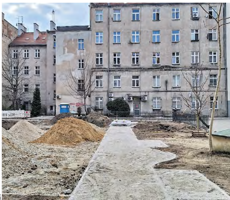
Wykopy i nowe nawierzchnie na podwórku przy ulicy Nowej
