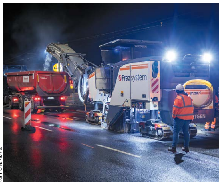
Frezowanie nawierzchni Powstańców Śl., luty 2026 – zdj. ilustracyjne
