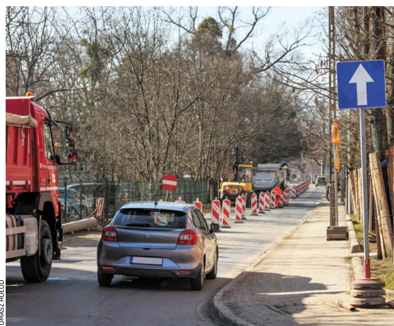
Na ulicy Przybyszewskiego rozpoczęły się prace remontowe
