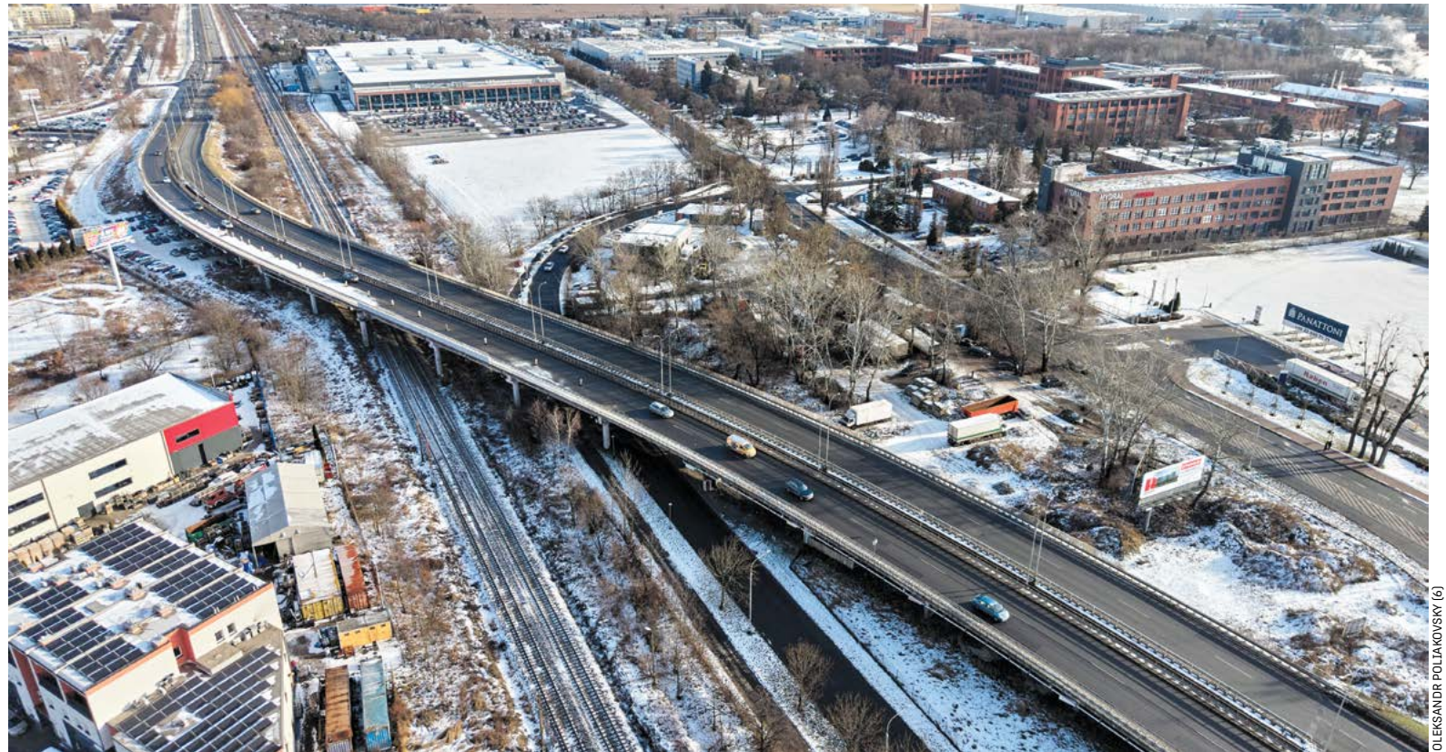
Estakady na Alei Sobieskiego będą remontowane etapami, żeby zminimalizować utrudnienia dla kierowców, prace trzeba skoordynować też z PKP
