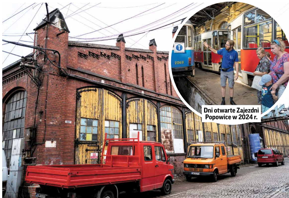
Planowany remont w zabytkowej Zajezdni Popowice obejmie elewację, dach, instalacje, a także stolarkę
