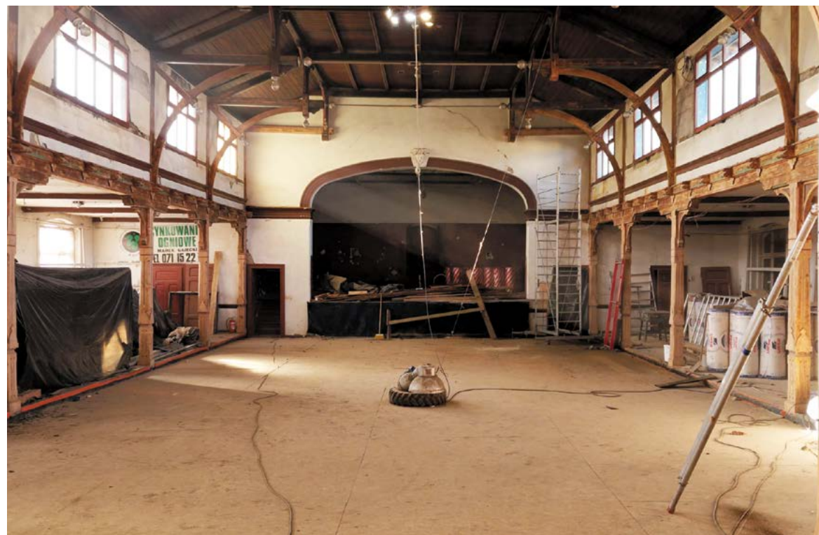
Po zakończeniu prac budynek „Lotnika” będzie nowoczesną i dostępną przestrzenią dla mieszkańców
