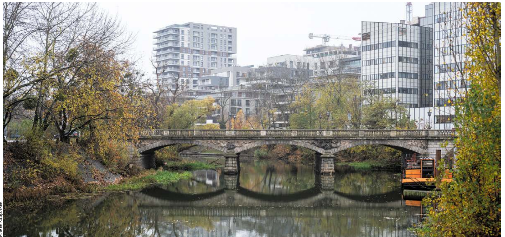
Most Oławski łączy dwie ulice na Przedmieściu Oławskim: ulicę Walońską (po stronie zachodniej) z ulicą Na Grobli (po stronie wschodniej)
