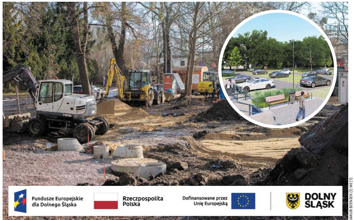
Prace nad budową Park&Ride przy stacji kolejowej Wrocław Leśnica wraz z wizualizacją przyszłego parkingu
