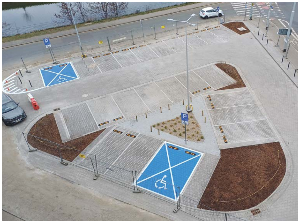
Wyremontowany parking u zbiegu Trzebnickiej i Wybrzeża Korzeniowskiego – wiosna 2025
