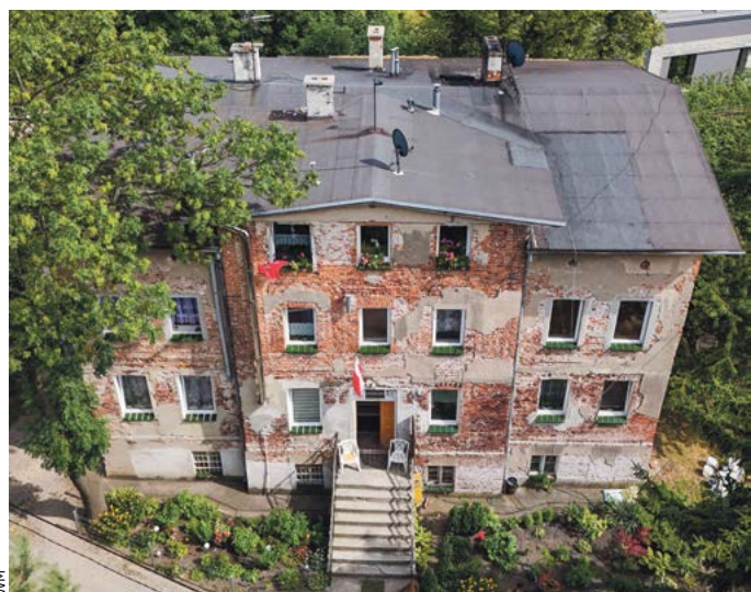
Remont zabytkowego budynku będzie kosztował ok. 1 mln zł
