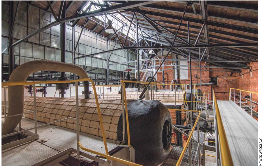
Potężne maszyny składają się wraz z architekturą na hydrotechniczny hit tamtych czasów
