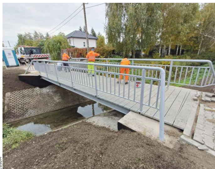
Remont kładki nad Kasiną trwa do 21.10, teraz jest dostępna
