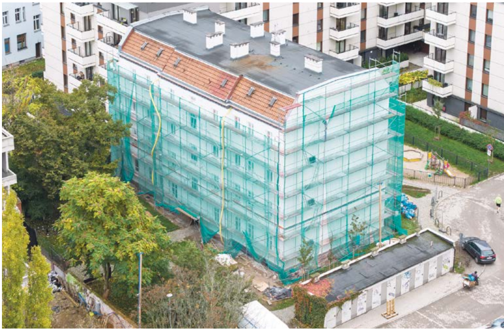
Budynek przy ul. Prądyńskiego 20a w trakcie pokrywania elewacji farbą izolacyjną, 24.10
