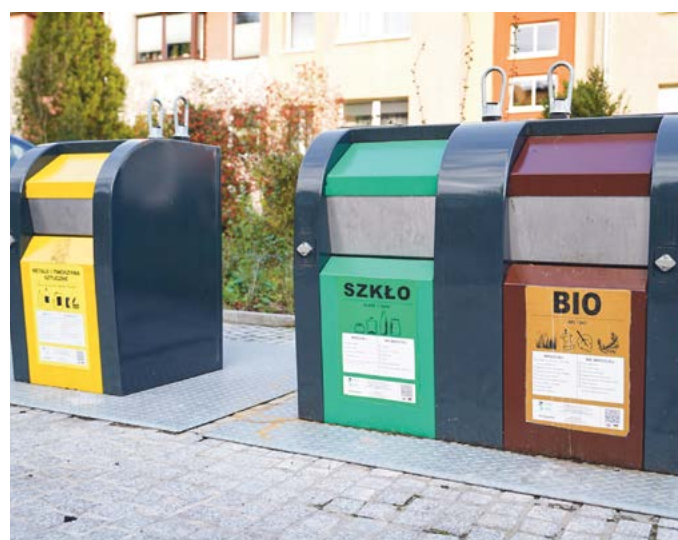
Pojemniki podziemne w południowej części Sępólna
