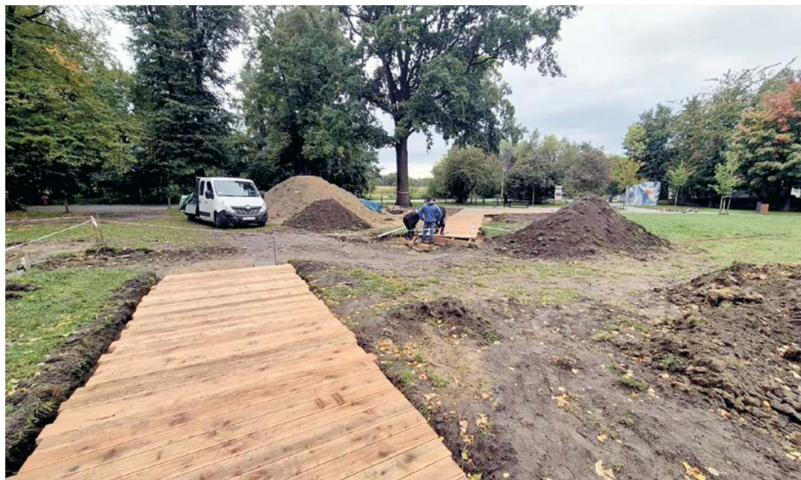
Budowa placu zabaw nad Jezioro Pawłowickim – trwa właśnie układanie drewnianych pomostów
