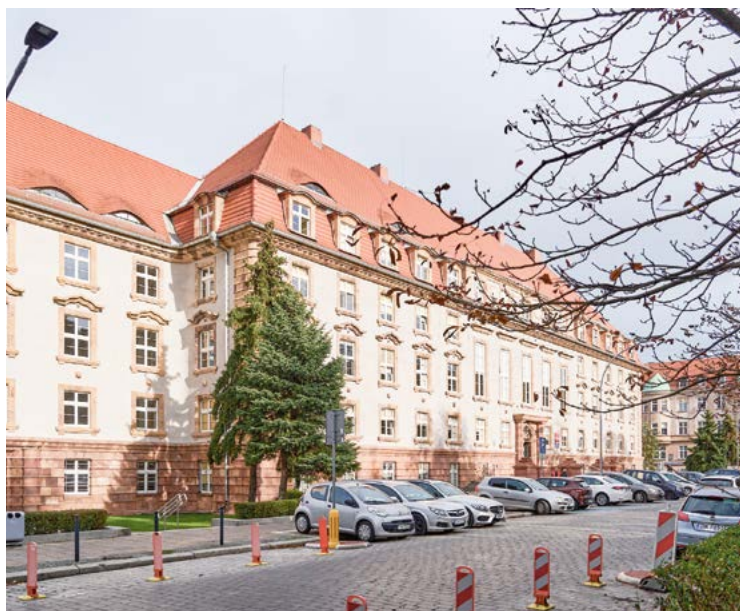
Budynek ZUS przy ul. Pretficza 11, zdjęcie archiwalne z 2024 roku
