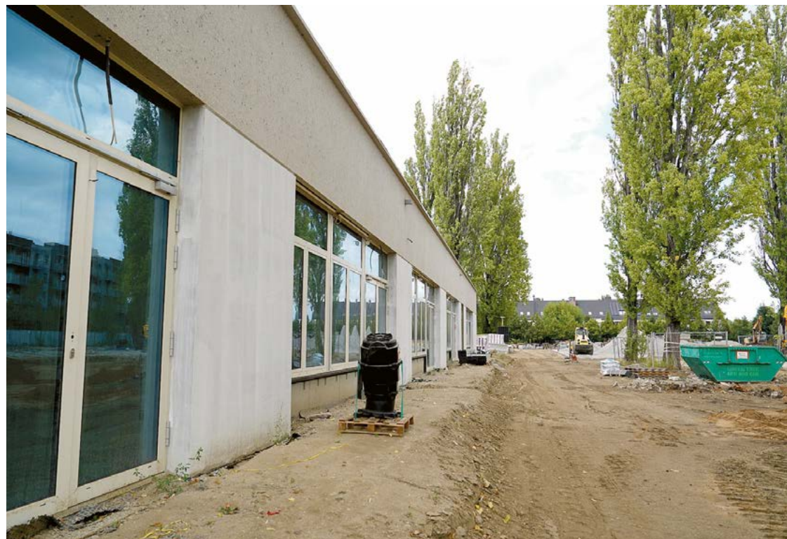
Stan prac na budowie ZSP na Zwycięskiej, sierpień 2025. Więcej zdjęć na: www.wro.news/ZSP-zwycieska
