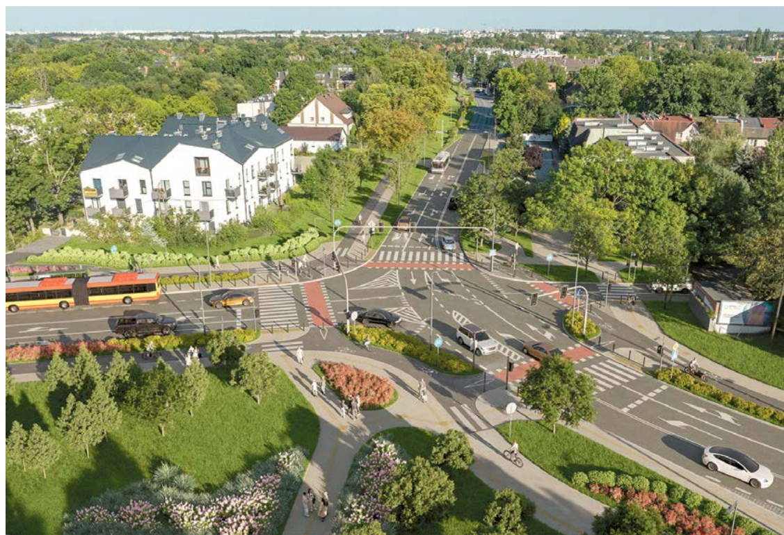
Tak po przebudowie wyglądać będzie skrzyżowanie ulic Awicenny, Wiejskiej i Mokronoskiej na Oporowie
