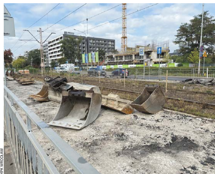
Trwają prace przy remoncie torowiska w ul. Tarnogajskiej
