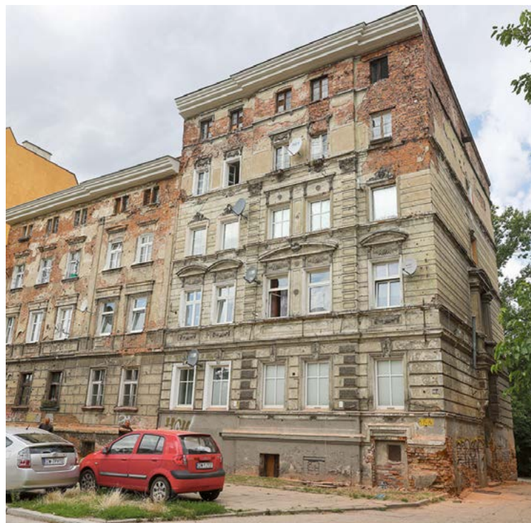
Budynek przy ul. św. Jerzego 21 – jeszcze na początku lipca 2025
