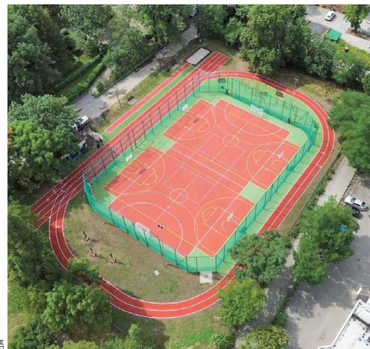
Boisko przy Czeskiej oddane do użytku dwa miesiące przed terminem
