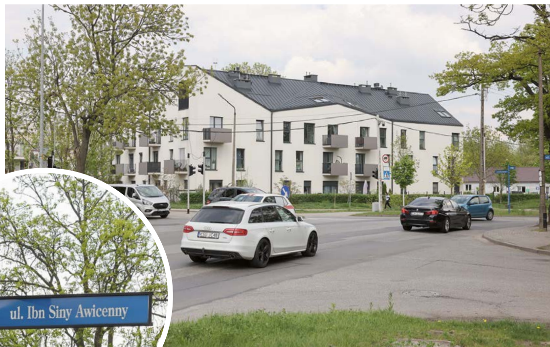
Roboty budowlane na skrzyżowaniu Mokronoskiej, Wiejskiej i Awicenny będą realizowane pod ruchem
