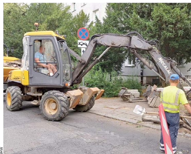
Remont ulicy Inżynierskiej z programu „Wrocław na dobrej drodze”
