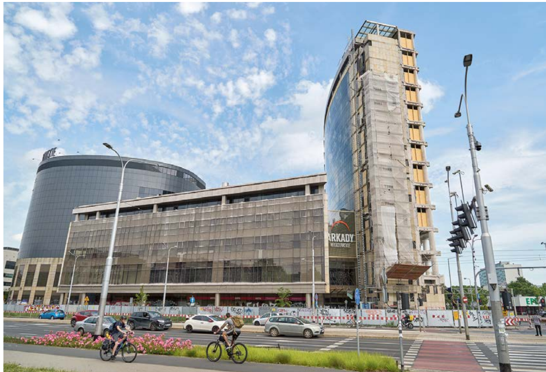
Widok na Arkady Wrocławskie podczas pierwszej części rozbiórki. Zdjęcie zostało zrobione w czerwcu 2025
