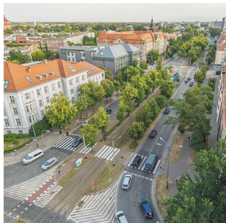
Remont ul. Powstańców Śl. ma zostać wykonany w ciągu pół roku
