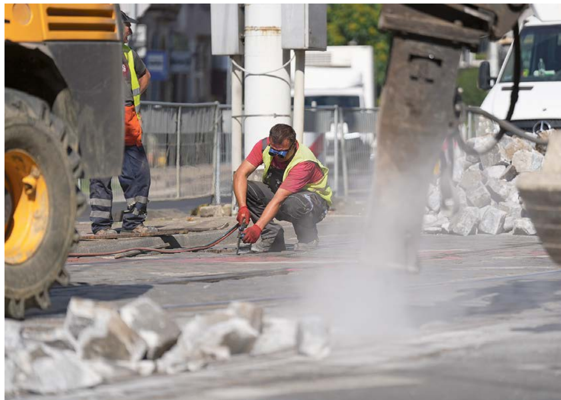
W ramach TORYwolucji robotnicy wymienią cztery rozjazdy w obrębie skrzyżowania Pomorska/Dubois
