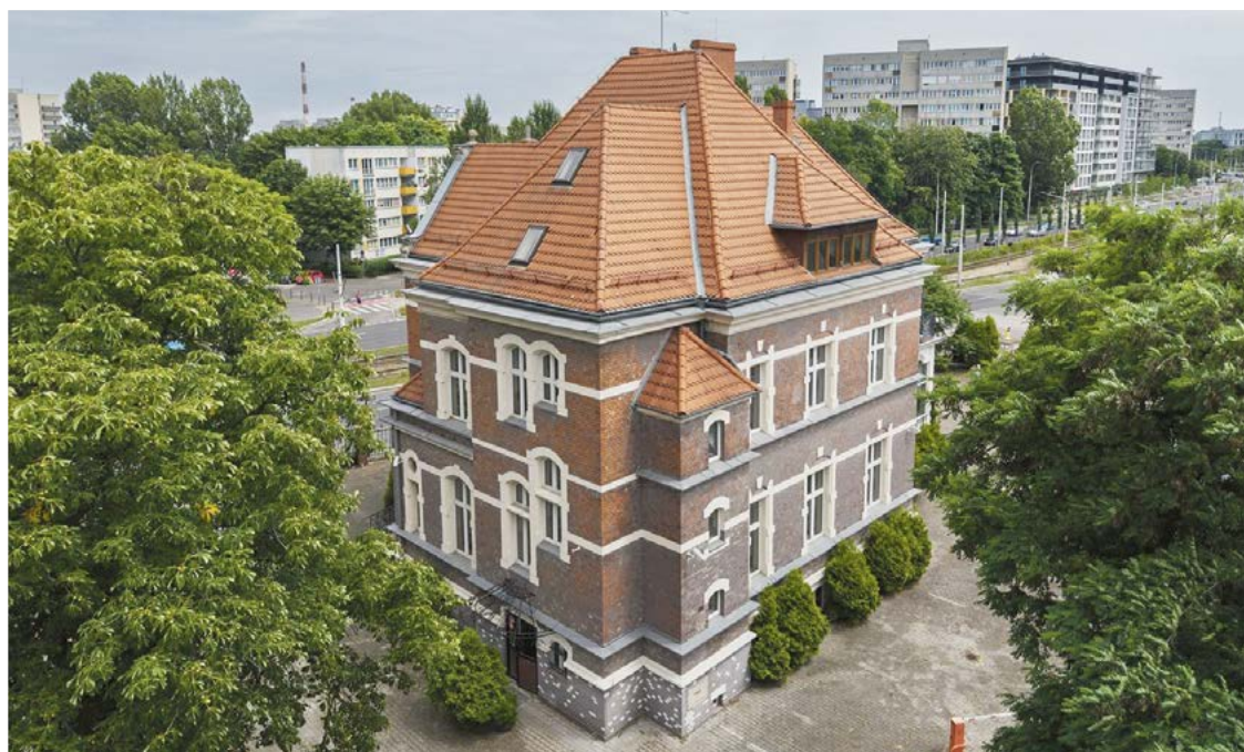
Tak wygląda willa pod adresem ul. Legnicka 42 jeszcze przed remontem, 23 czerwca 2025 roku
