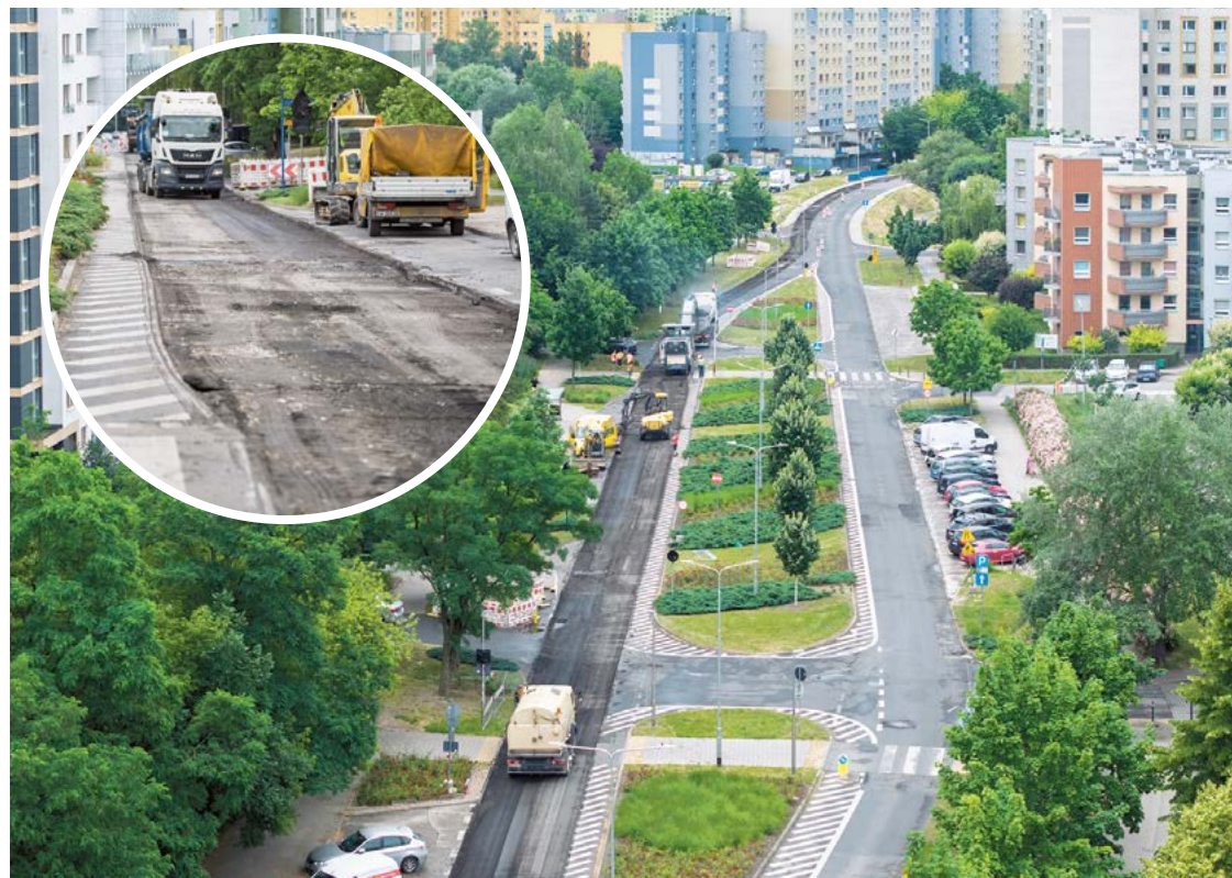
W poniedziałek 23.06 robotnicy Pro Tra Building rozpoczęli prace na Bajana
