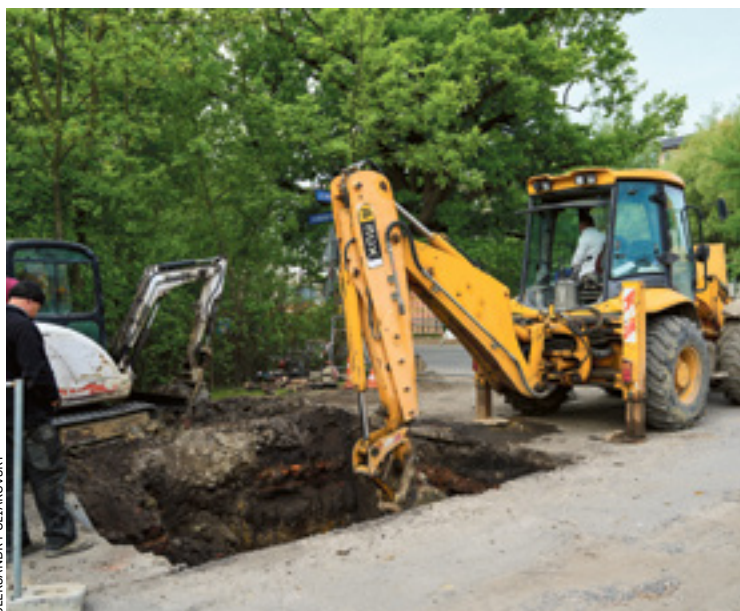
Na osiedlu Żerniki powstanie nowa sieć kanalizacji sanitarnej
