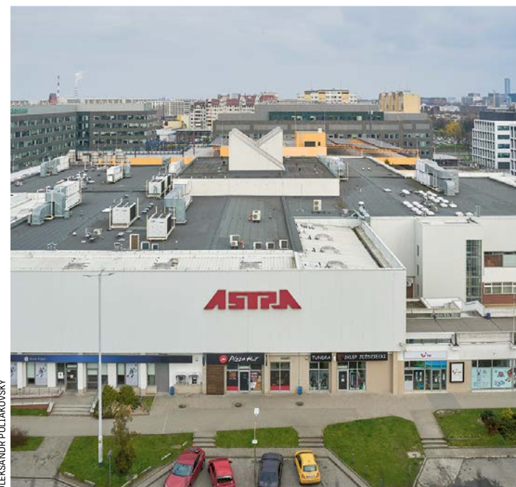
Centrum Handlowe Astra przy ul. Horbaczewskiego już po remoncie
