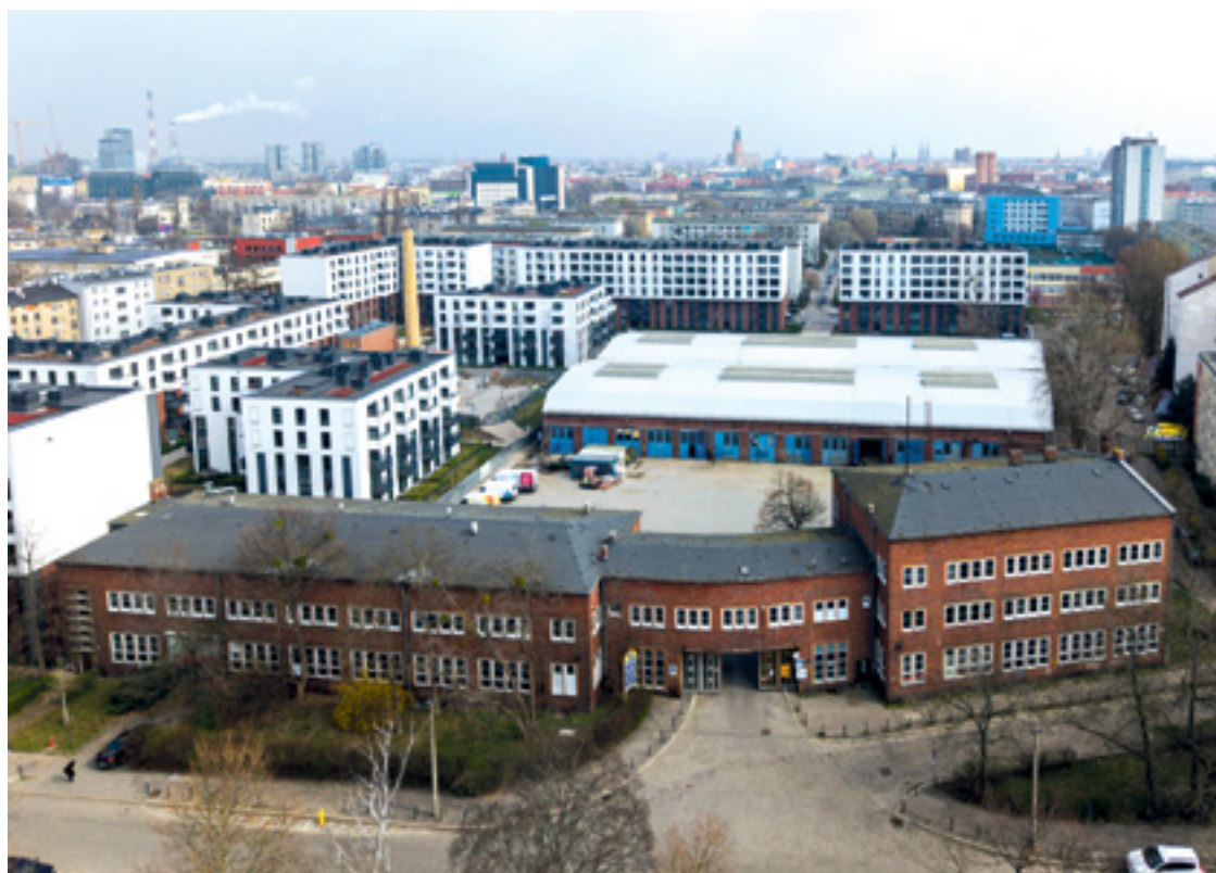
Widok na halę – przyszłą galerię główną BWA Wrocław. Na horyzoncie – wieża kościoła św. Elżbiety
