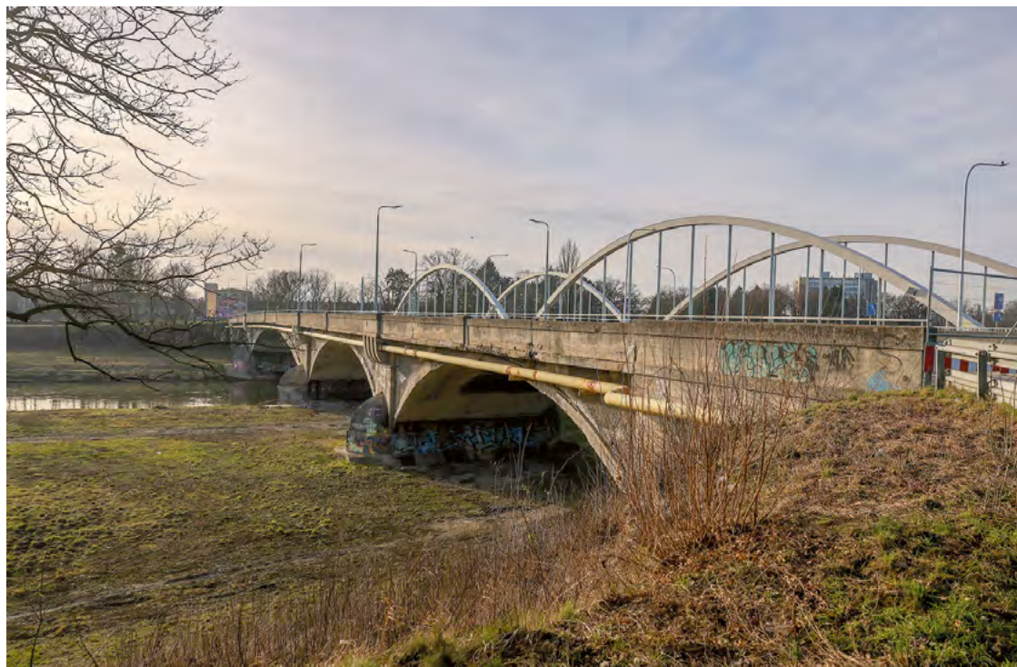
Na pierwszym planie stare mosty, wymagające odbudowy, w tle widać przęsła nowych, znacznie większych
