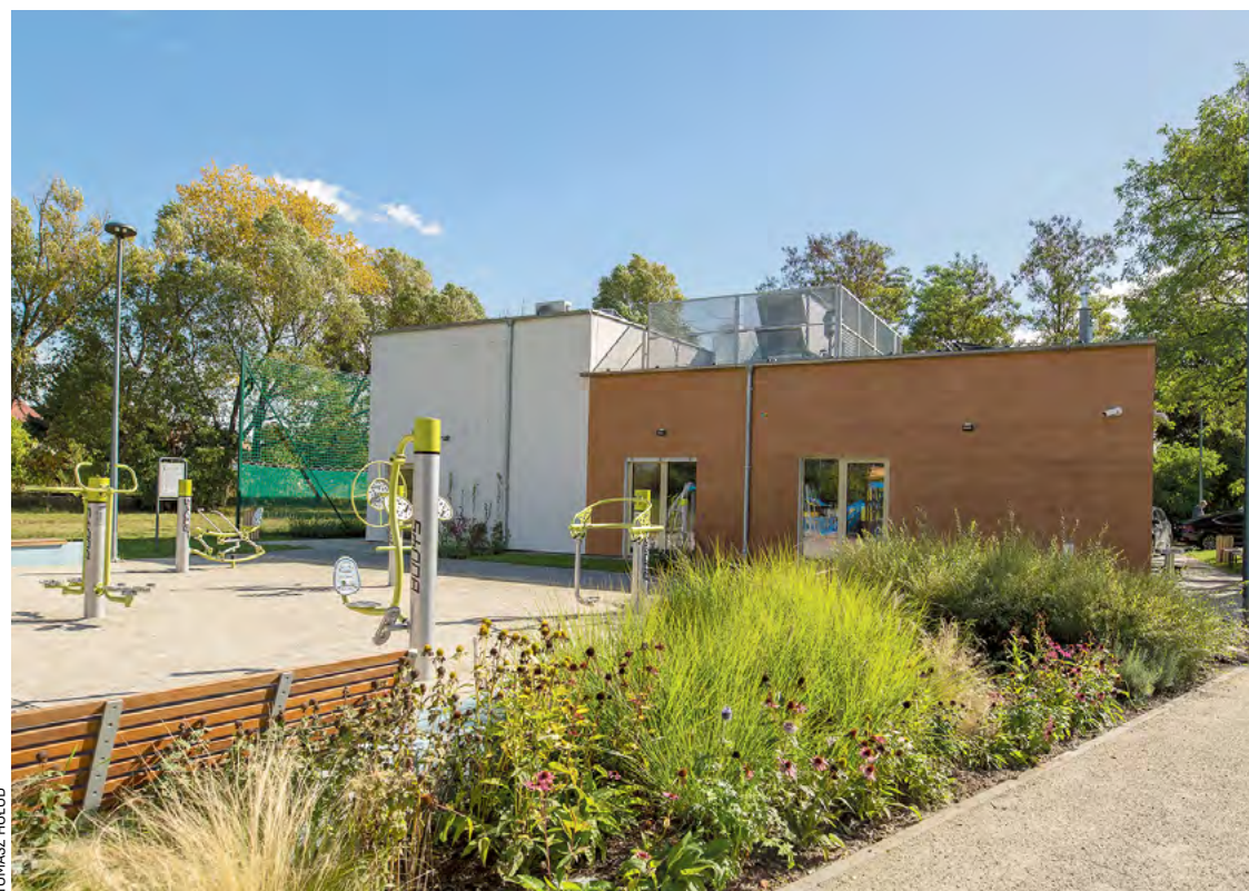
CAL na Kowalach powstał w niecałe 2 lata, budowa kosztowała prawie 1,7 mln zł, otwarto go 30.09.2021
