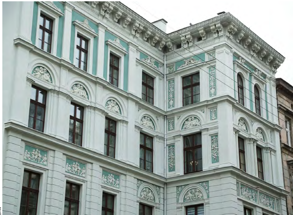
UMW Przedmieście Oławskie, kamienica z ul. Kniaziewiczza 17 – po remoncie stanowi prawdziwą ozdobę osiedla
