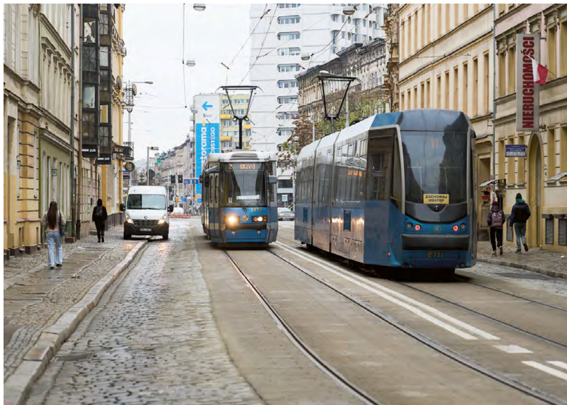
Na ulicy Szczytnickiej oddano niedawno wyremontowane torowisko, teraz czas na dalsze koncepcje
