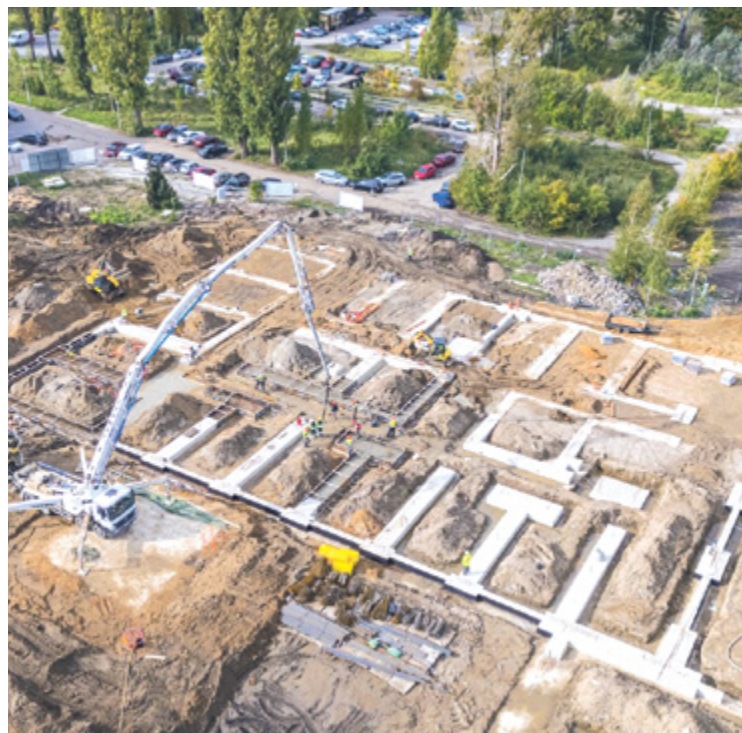
Zdjęcia fundamentów ZSP wykonane dronem 8 października
