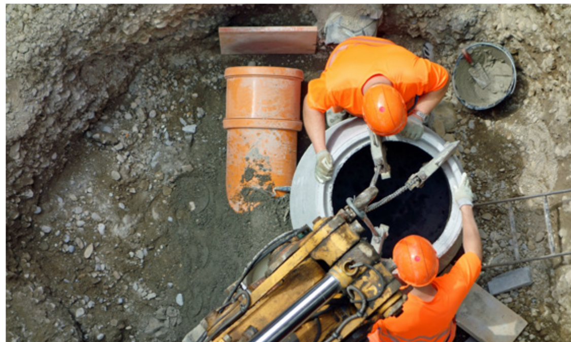
Dzięki podłączeniu do sieci kanalizacyjnej zdecydowanie zmniejszą się rachunki za odbiór ścieków
