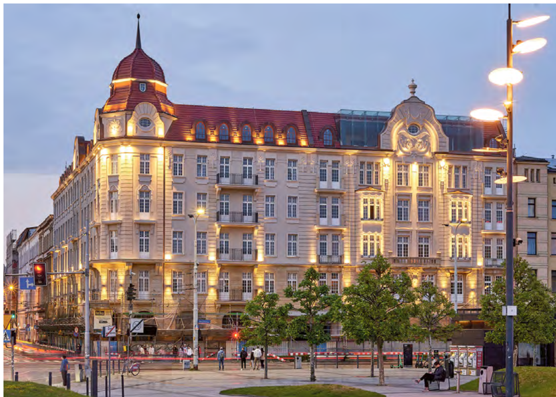
Renowacja elewacji hotelu Grand – tytuł Modernizacja Roku 2023 w kat. elewacja i termomodernizacja
