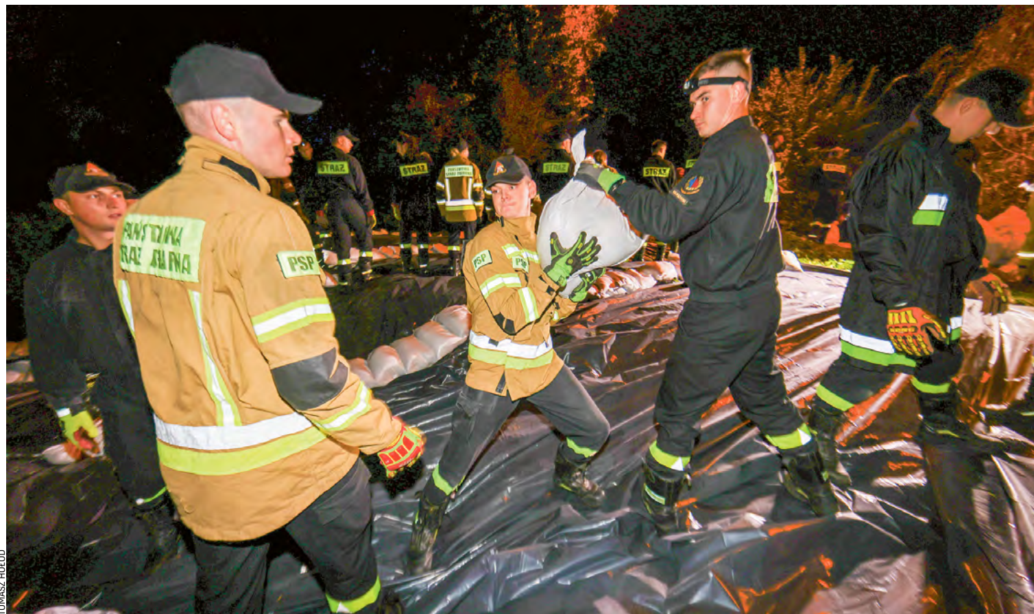
Przez niemal całą noc z 16 na 17 września na wrocławskich Marszowicach straż pożarna pomagała umacniać wały przeciwpowodziowe
