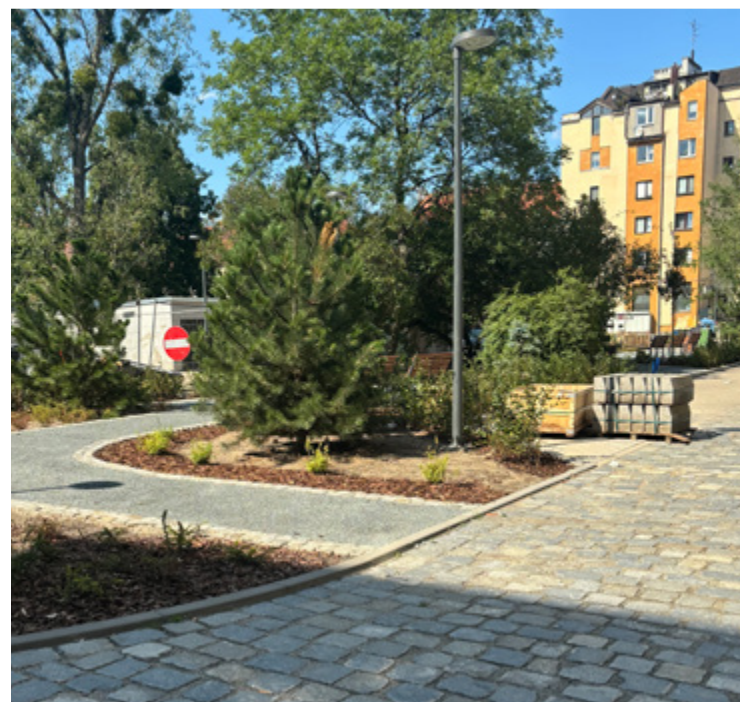
Wykonawca zakończenie remontu przewiduje na początek 2025 roku
