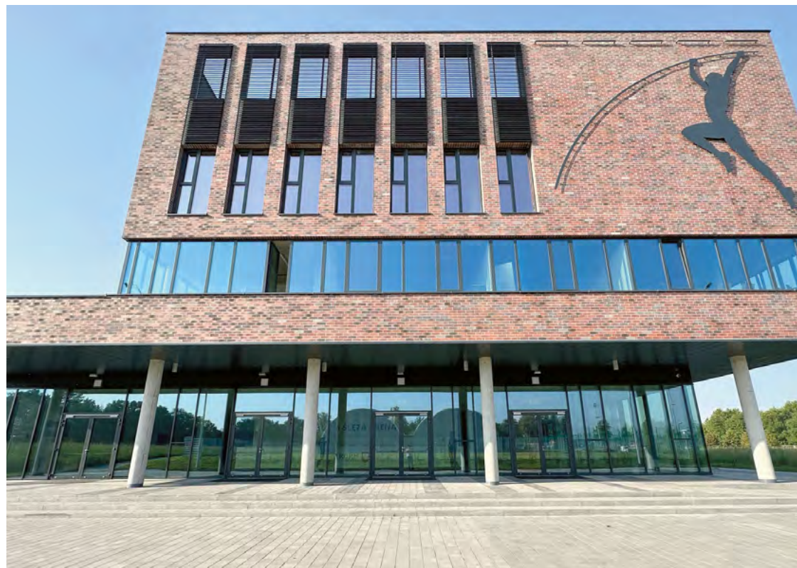
Treningi w ramach „Lata z KGHM Śleza Areną” będą odbywać się w nowej hali przy ul. Kłokoczyckiej 1
