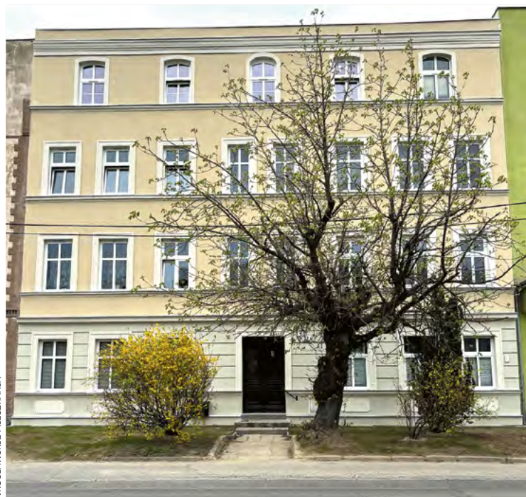
Kamienica przy ul. Czajkowskiego 32 przeszła już termomodernizację
