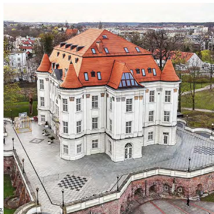
Szacuje się, że prace remontowe na zamku potrwać ośmiu miesięcy
