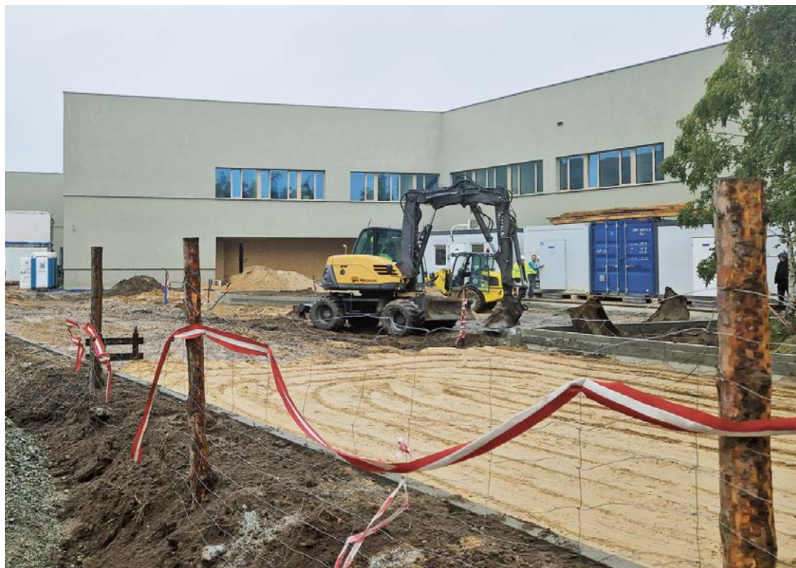
Trwają intensywne prace przy budowie Zespołu Szkolno-Przedszkolnego przy ulicy Cynamonowej
