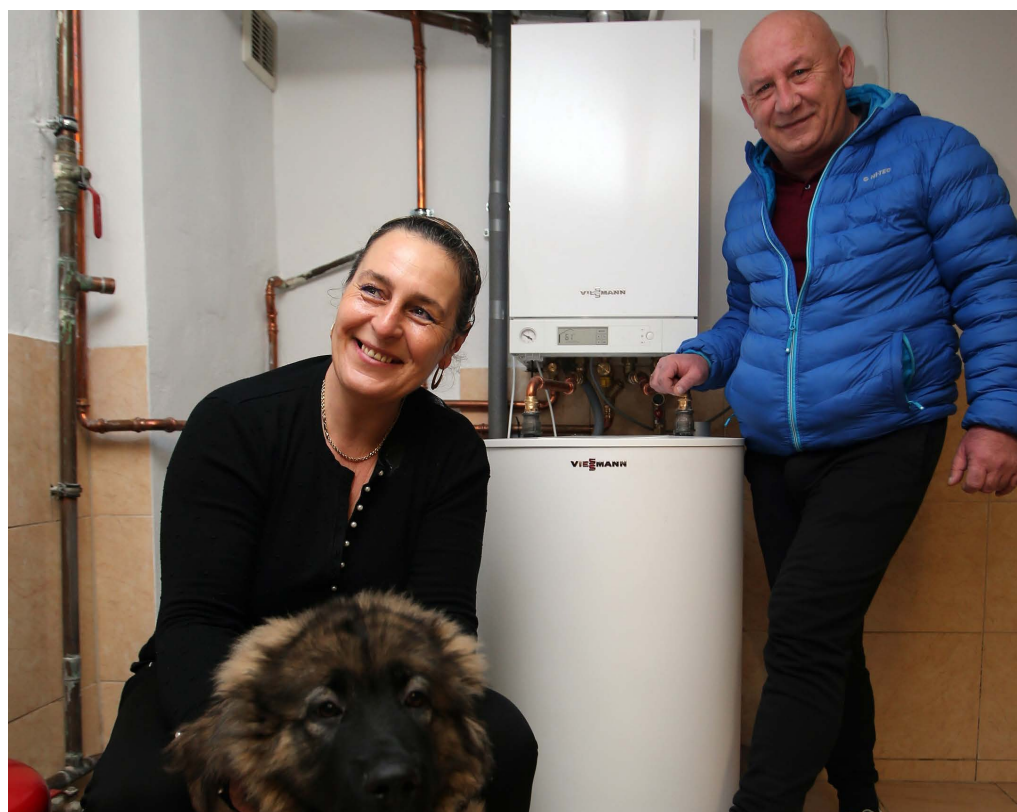
Wyremontowane pomieszczenia, gdzie kiedyś leżał koks, zajmuje dziś ukochany pies
