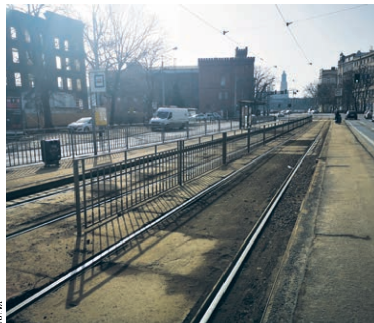
Przystanek jest teraz ulokowany pomiędzy jezdniami
