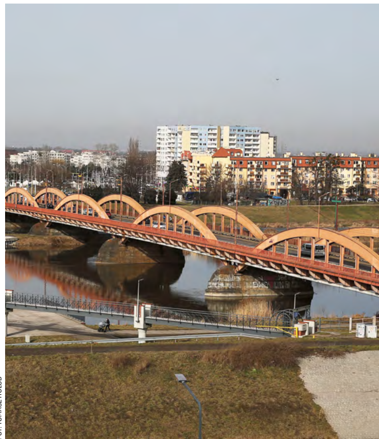
Mosty zostaną poszerzone tak, żeby powstały ścieżki rowerowe
