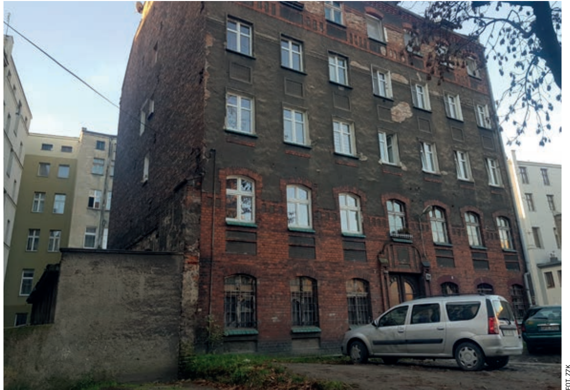
Zaplanowany remont kamienicy potrwa do 2023 r.
