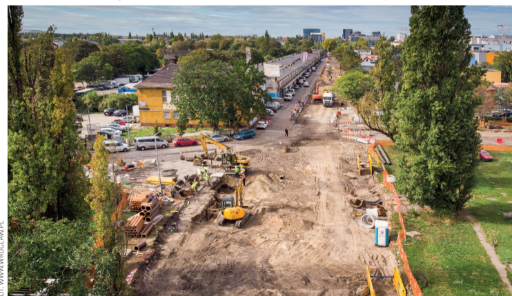
Teren budowy trasy tramwajowej na Popowice
