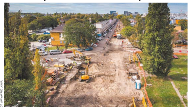
Teren budowy trasy tramwajowej na Popowice
