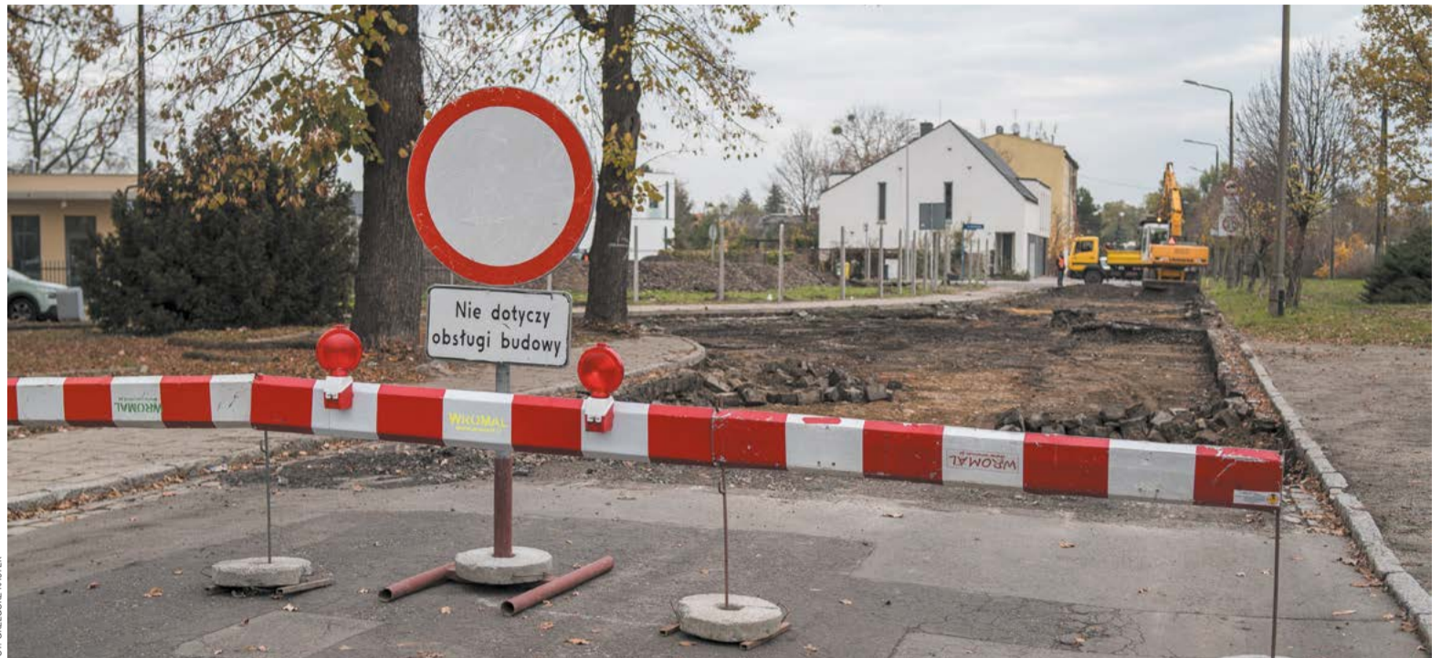
Prace na ulicy Krotoszyńskiej potrwać do końca bieżącego roku
