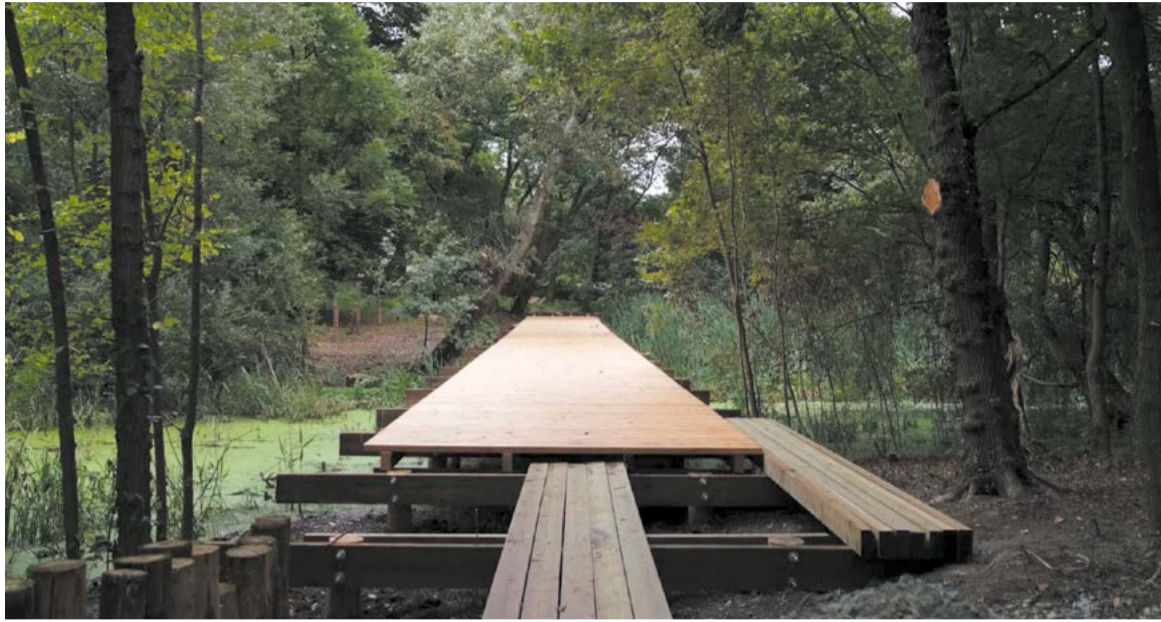
Budowa kładki na palach nad stawem starorzecza Odry
