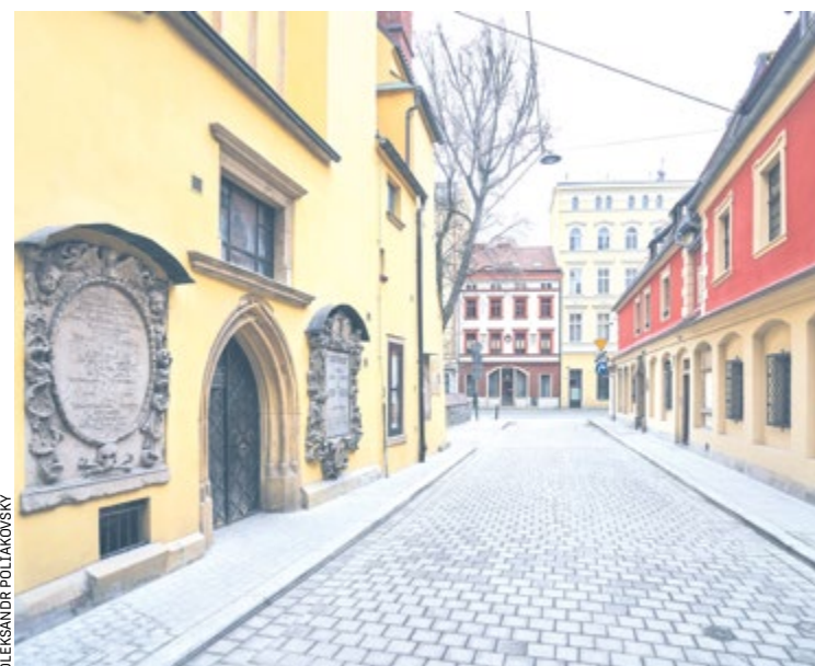
Uliczka po remoncie jest teraz gładka, wymienione zostały też chodniki
