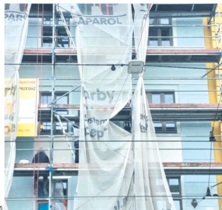
Elewacja frontowa – zaszpachlowana i pomalowana od góry do I piętra
