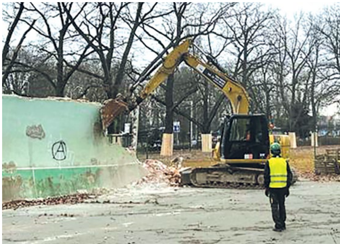
Początek pierwszego etapu budowy hali rozpoczęty. Robotnicy wyburzają starą ściankę tenisową
