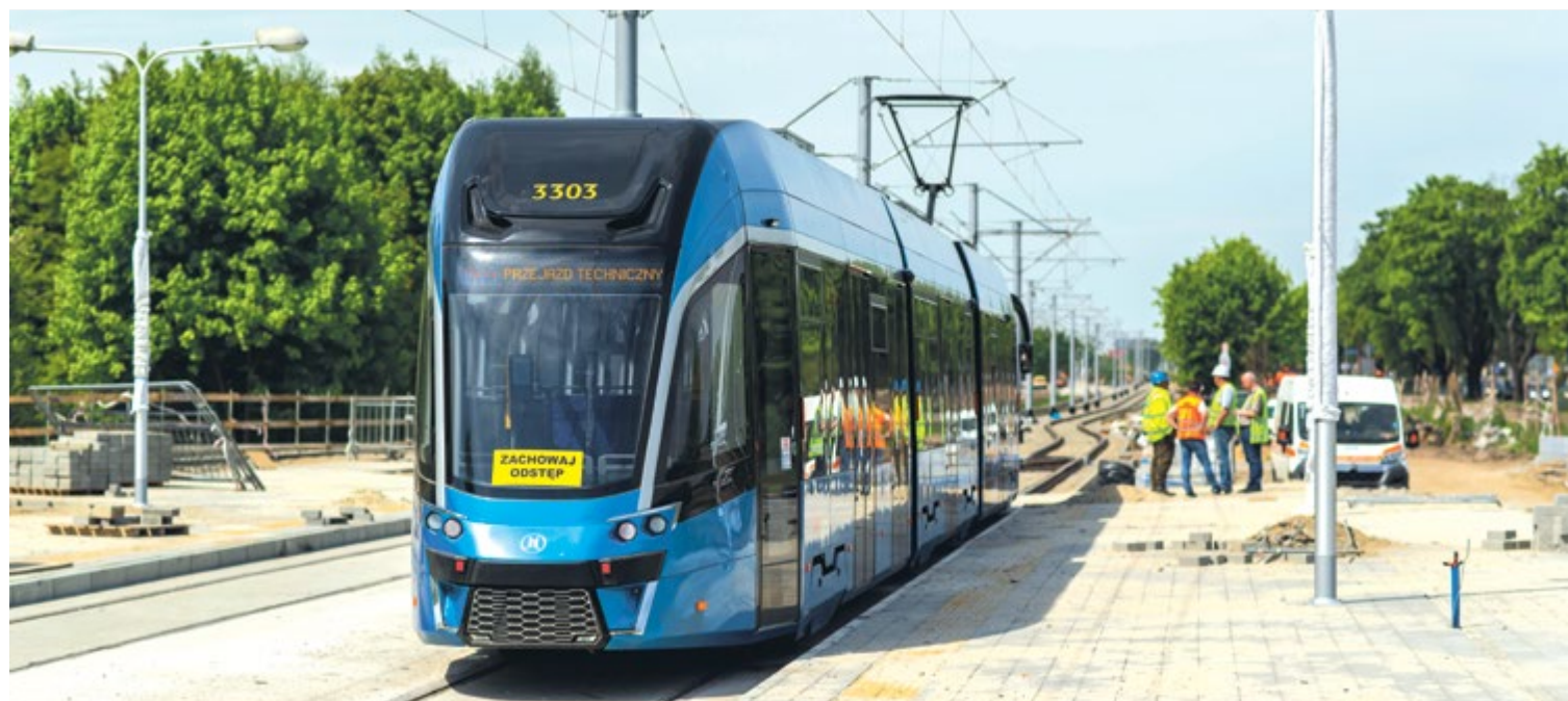
Budowa nowego torowiska przez osiedle Popowice kosztuje około 222 mln złotych i jest dofinansowana z funduszy Unii Europejskiej
