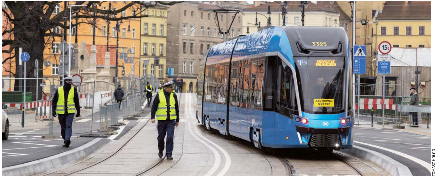
Próbny przejazd tramwaju po wyremontowanym torowisku przez mosty Pomorskie. Zgodnie z rozkładem będą po nich jeździć jesienią
