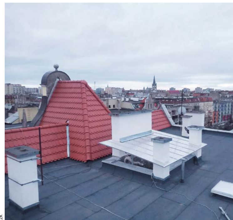
Budynek przy ul. Pereca 13 ma teraz dach, który ulew się nie boi
