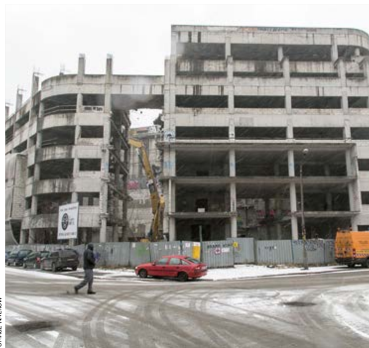
Tak wyglądała rozbiórka parkingu przy nasypie kolejowym w 2017 r.
