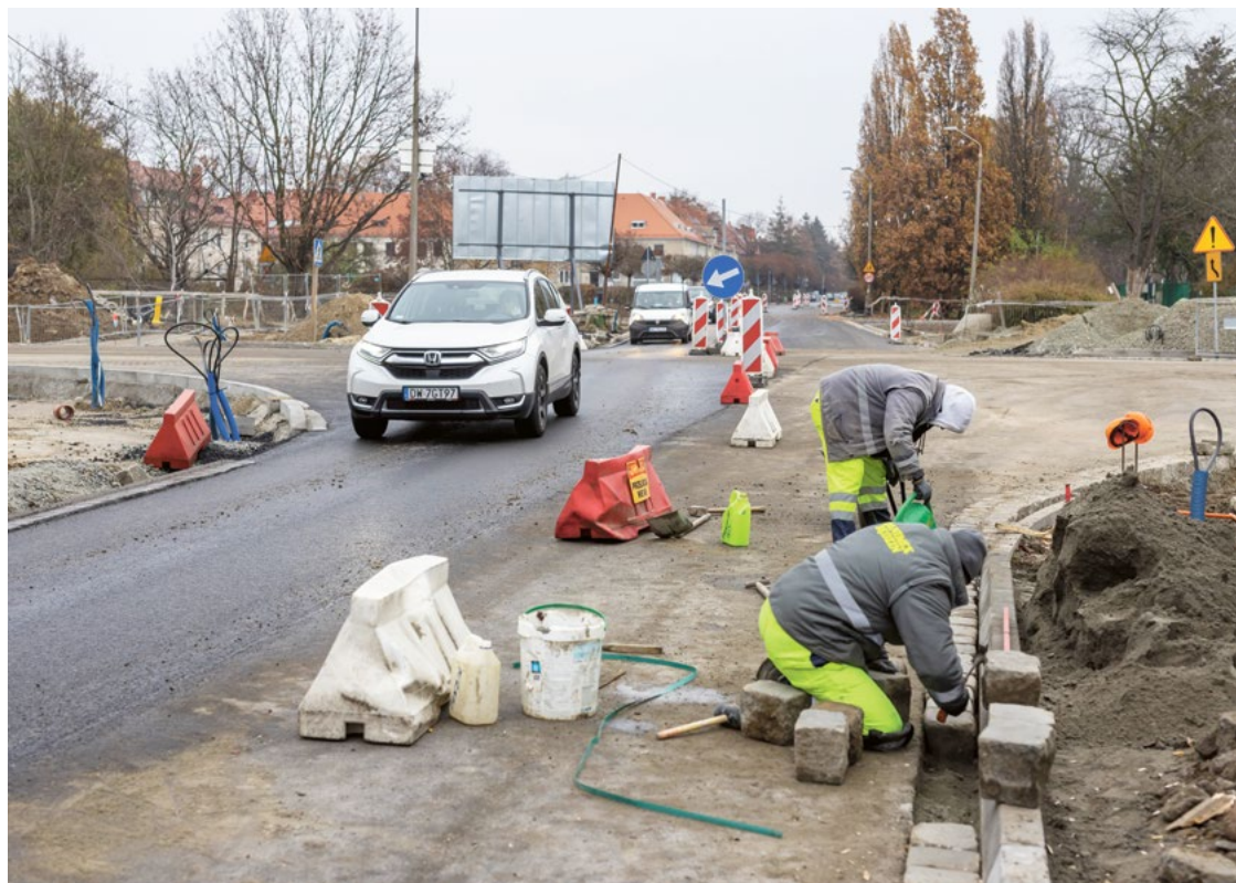
Robotnicy właśnie pracują przy ul. Dembowskiego i Olszewskiego, gdzie układają asfalt i chodniki
