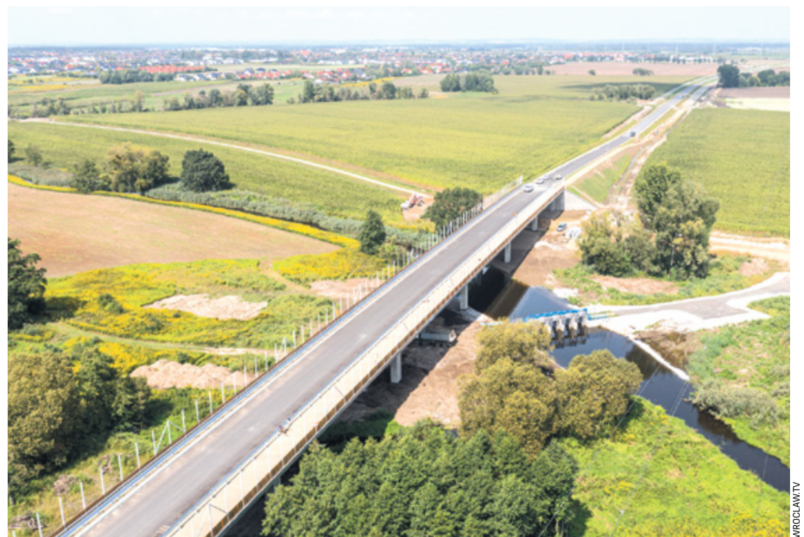
Budowa Wschodniej Obwodnicy Wrocławia, sierpień 2022. Północny odcinek między Długołęką a Łanami
