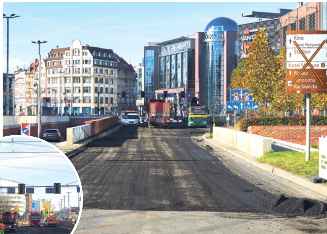
Nawierzchnia ul. Oławskiej została sfrezowana, żeby ułożyć na niej nowy asfalt
