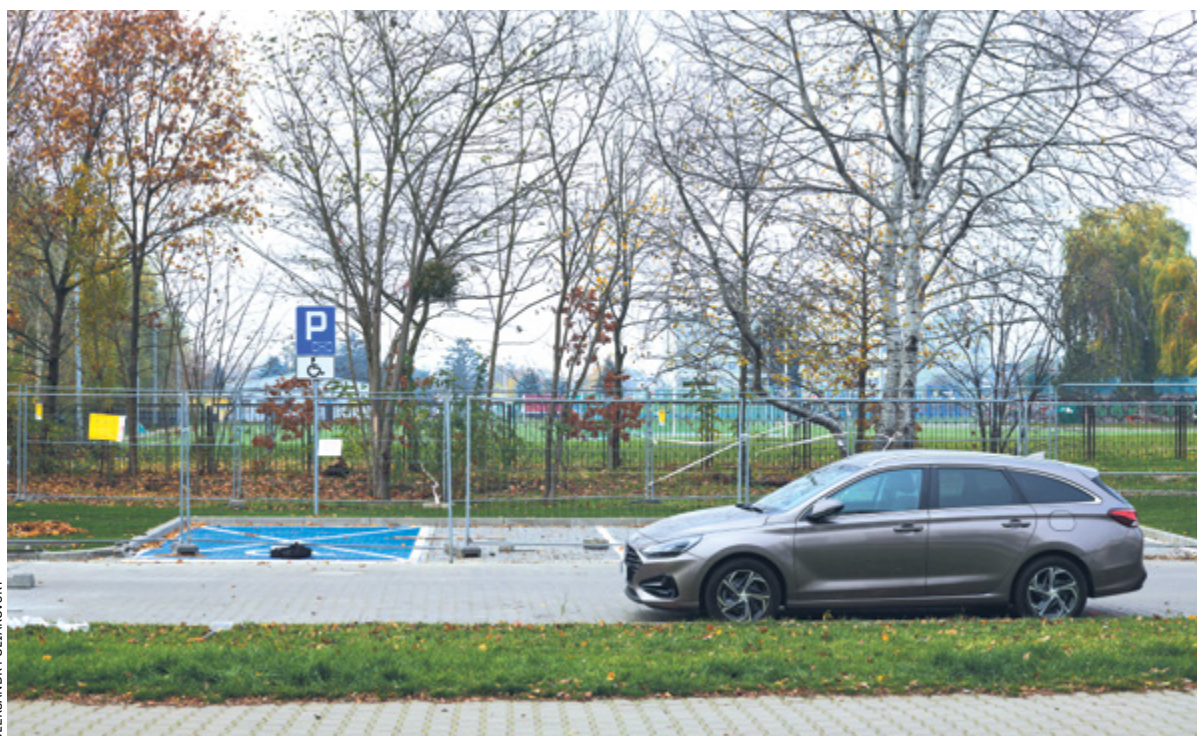
Prace przy budowie nowego parkingu na Gądowie dobiegają już końca. Powstanie tam 50 miejsc postojowych
