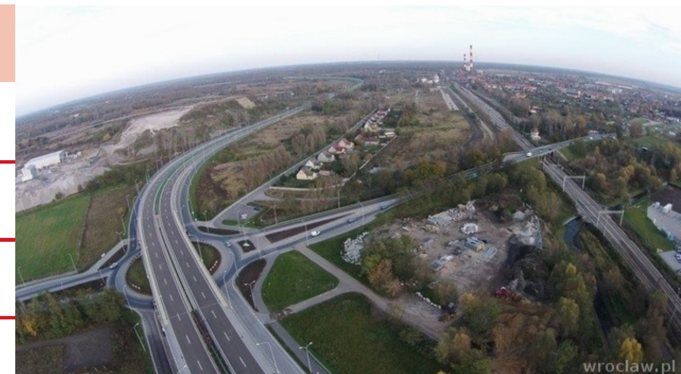
Dwupoziomowe skrzyżowanie Wschodniej obwodnicy Wrocławia i DK 94 koło Siechnic; źródło: wroclaw.pl
