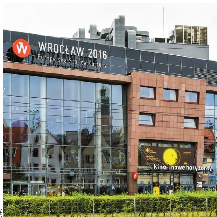
Modernizacja kina przy ul. Kazimierza Wielkiego potrwa kilka miesięcy
