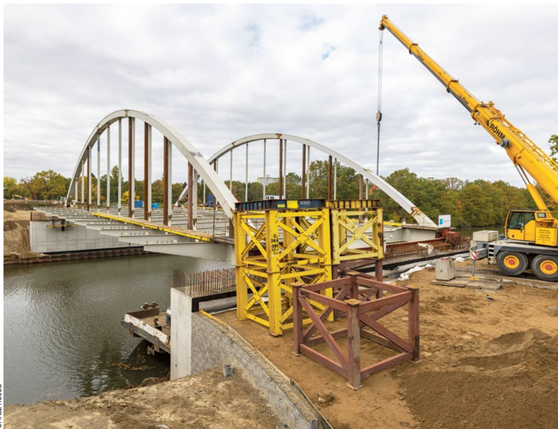
Dzięki barce konstrukcja mostu została nasunięta nad Odrą. Most waży 267 ton i ma 52 metry długości
